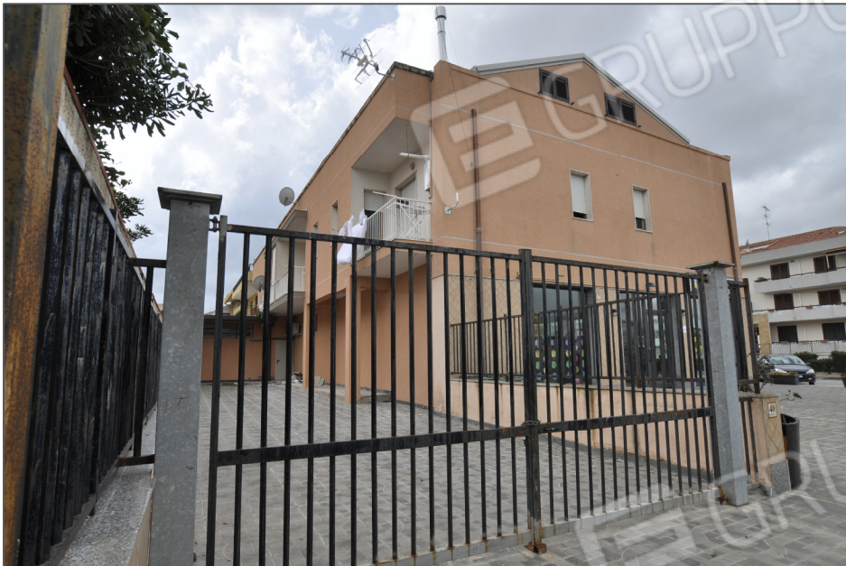
FOTO 2 - Vista esterna Fabbricato -
