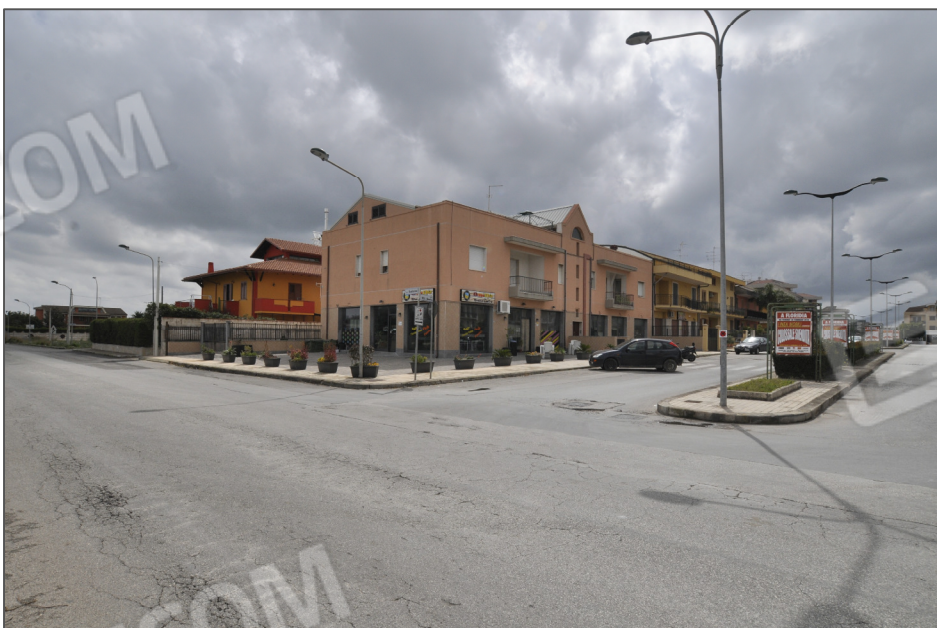
FOTO 3 - Vista esterna Fabbricato - Viale Vittorio Veneto angolo Via Scalorino -
