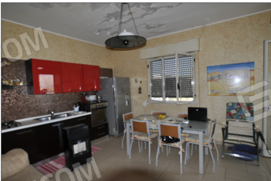
FOTO 6 - Vista interna - Cucina -
