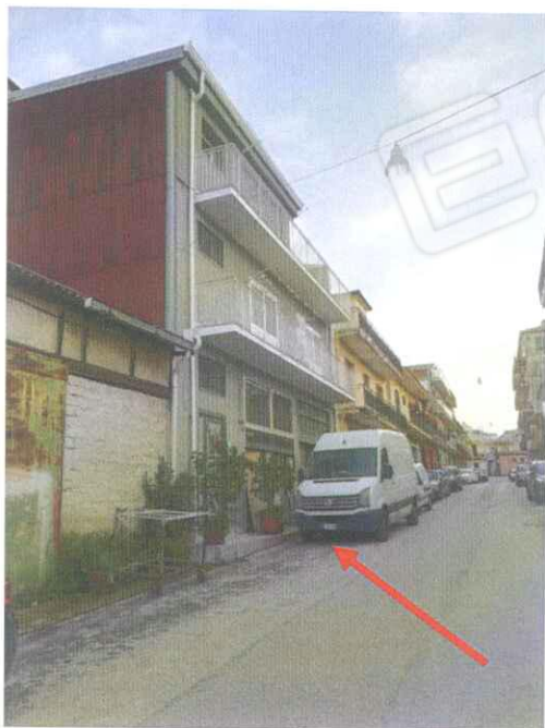
foto 1 – via Pio X n. 18 – accesso al magazzino
