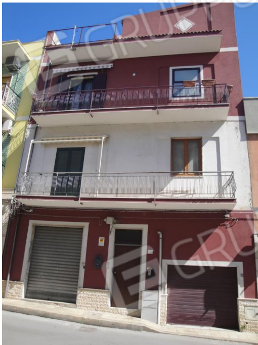
foto 1_ veduta del prospetto su via Palestro
