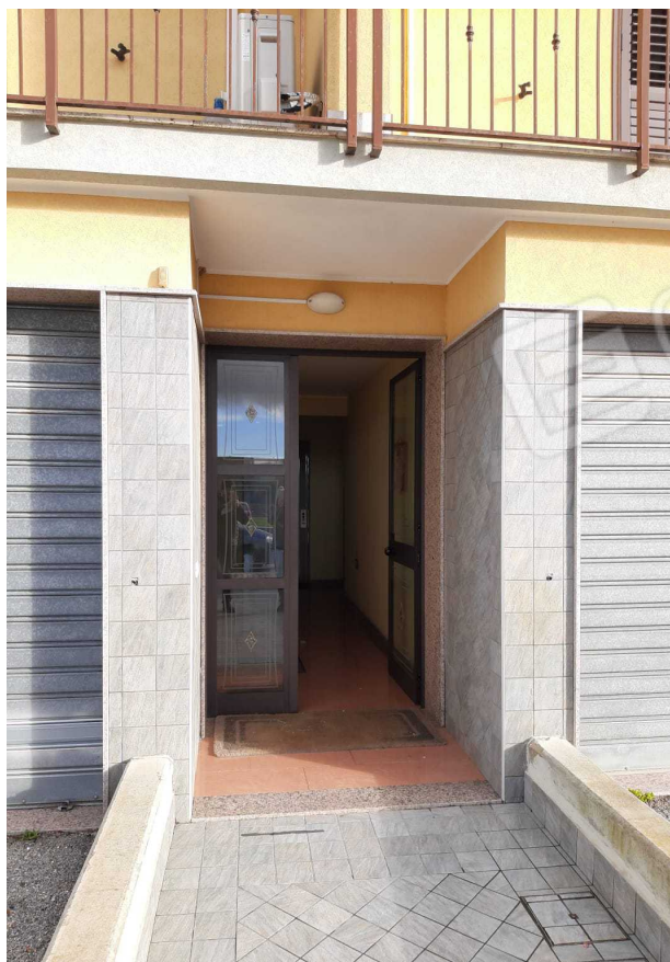
G.04A – Esterno lato Ovest – Portone d'ingresso all'atrio e vano scala
