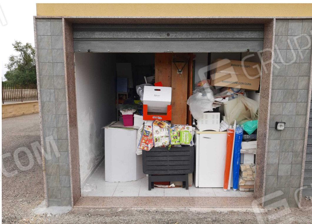
G.04B – altra Veduta dal lato Ovest. Ingresso all'immobile B da spazio esterno condominiale
