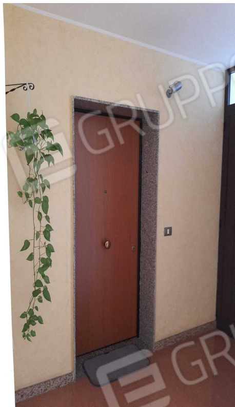
G.05A – Porta d'ingresso Immobile A – Piano terra, int. 1 .
