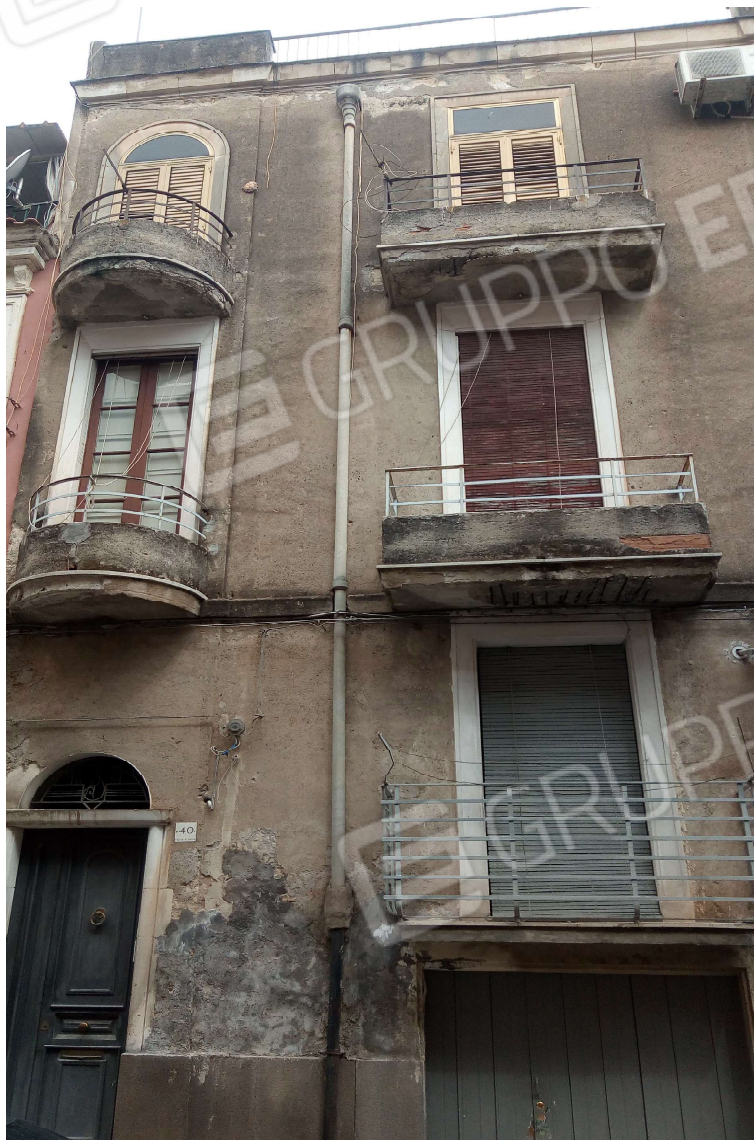
foto n.1: Lotto n.1 Prospetto Fabbricato su Via Palestrina n. 40 (appartamento al piano secondo)
