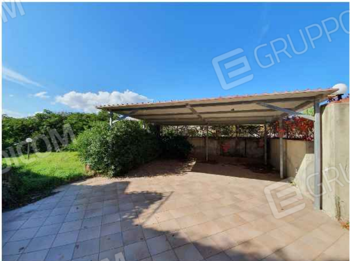
Foto 02 — Vista tettoia abusiva
