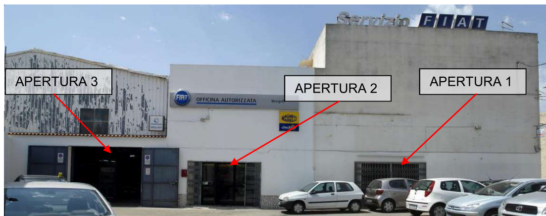
FOTO 1 - Prospetto nord est
