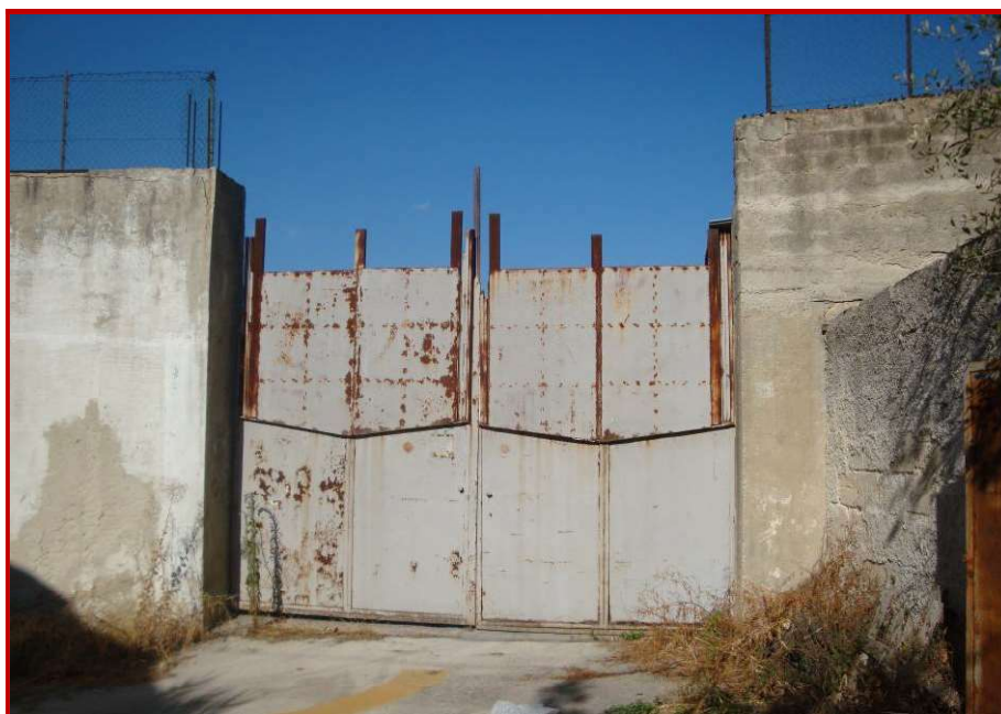
FOTO 3 - Prospetto sud ovest- apertura carrabile
