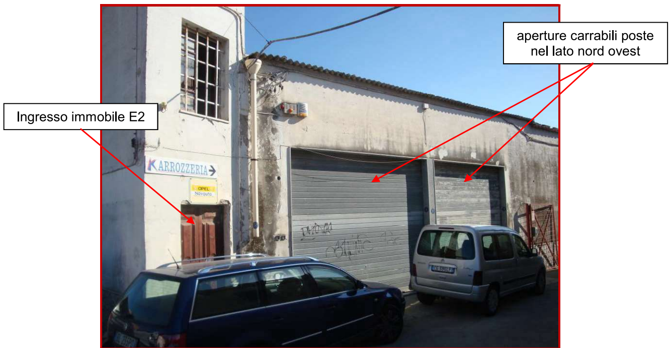
FOTO 2 - Prospetto nord ovest
