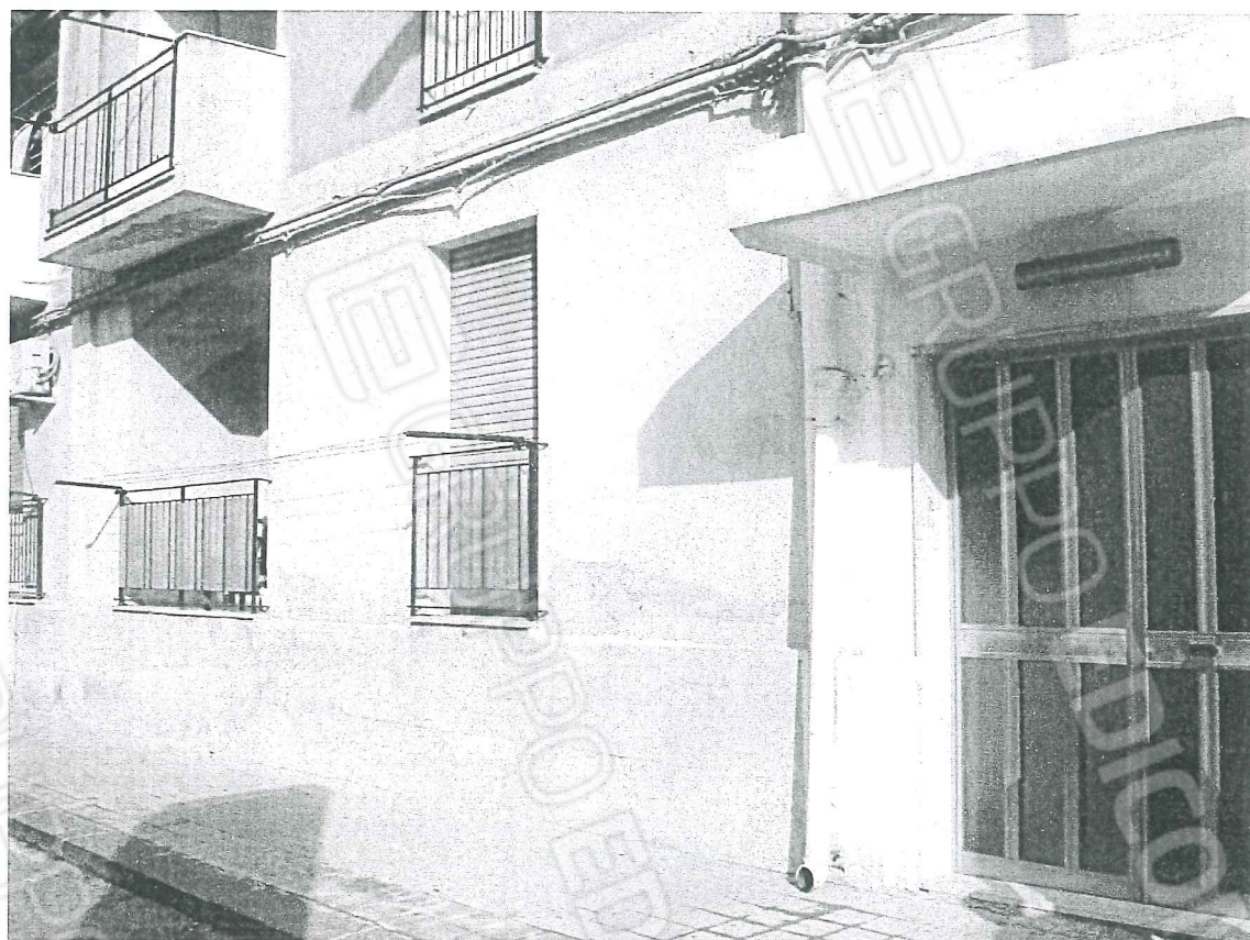
VISTA DEL FRONTE PROSPICIENTE LA VIA FRANCICA NAVA, CON INGRESSO DAL CIVICO N. 3
