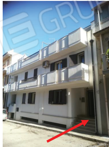
foto 2 – accesso edificio via Cile n. 25
