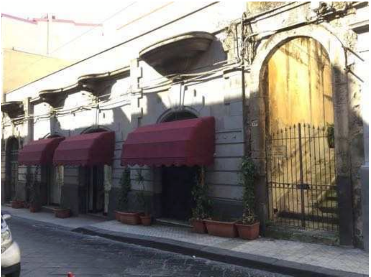
fig. 3 – – Prospetto su via Murganzio
