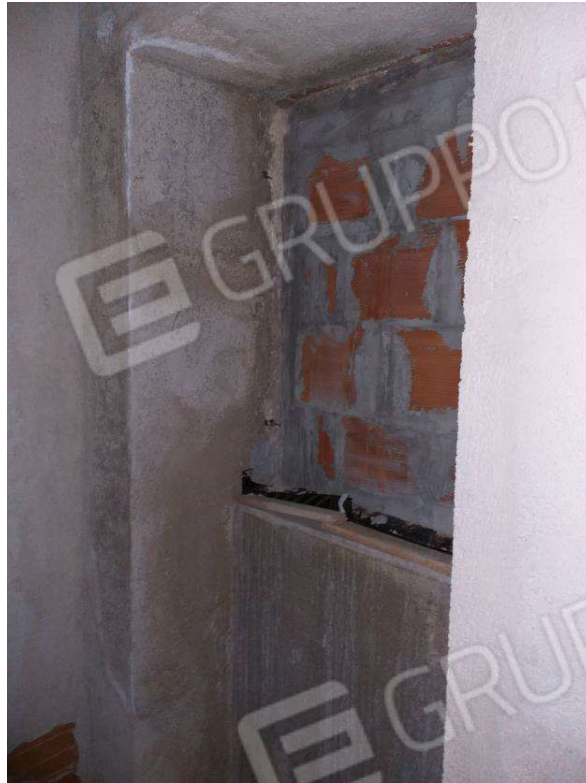
Foto 11_ particolare di una finestra murata
