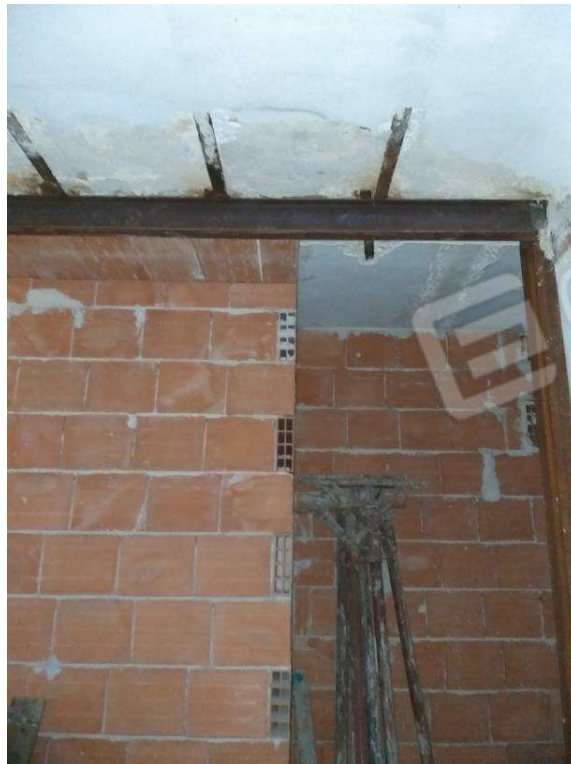
Foto 12_ particolare della trave IPE
