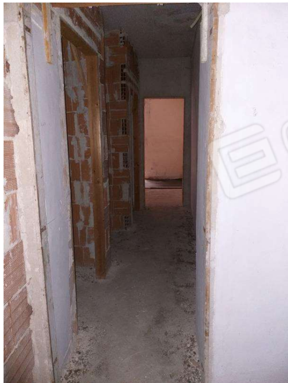
Foto 6_U.I. in ristrutturazione
