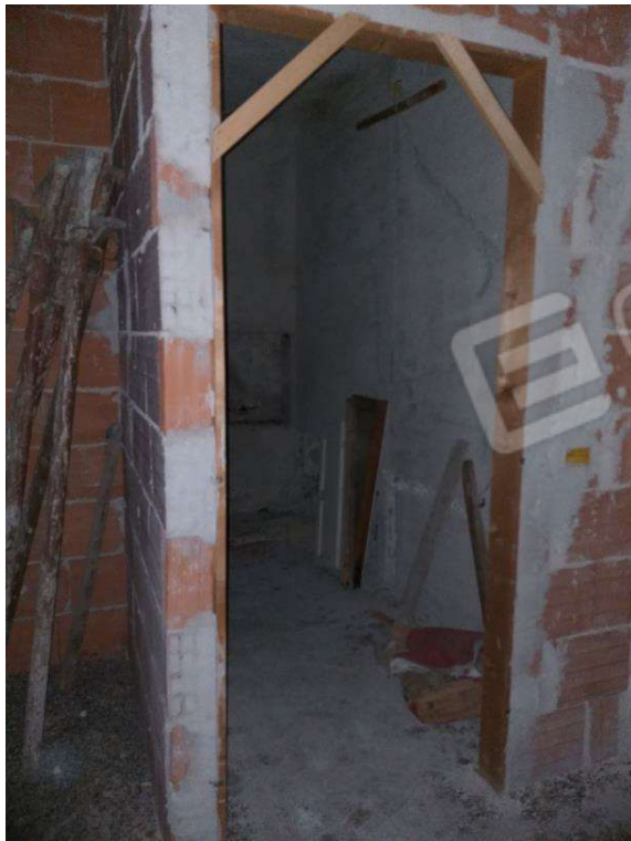
Foto 10_ U.I. in ristrutturazione
