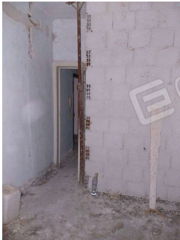
Foto 8_U.I. in ristrutturazione
