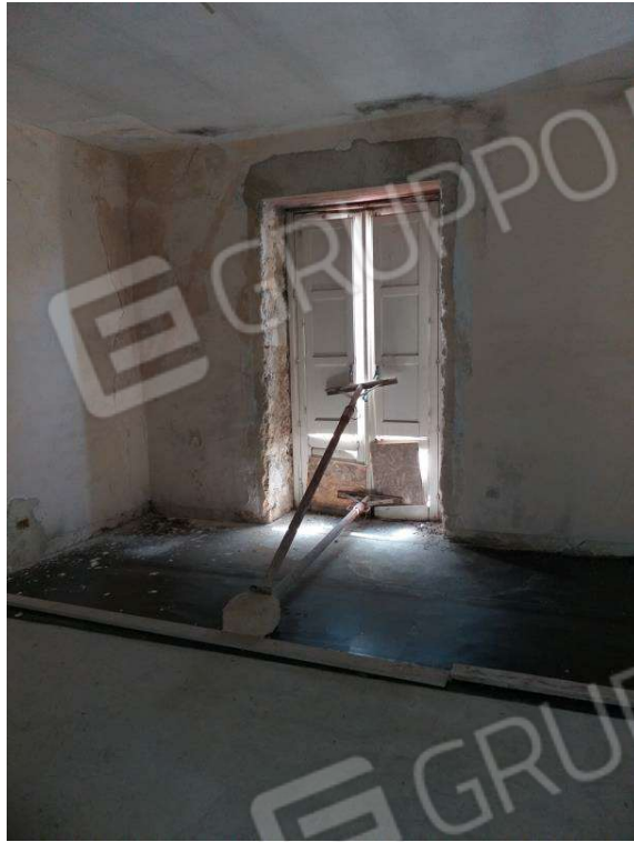
Foto 9_ U.I. in ristrutturazione
