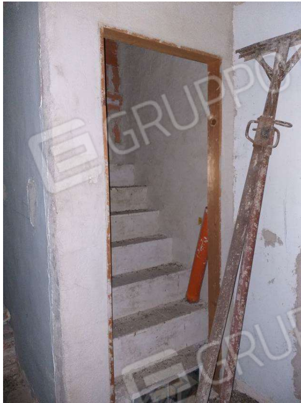
Foto 7_accesso con gradini murato
