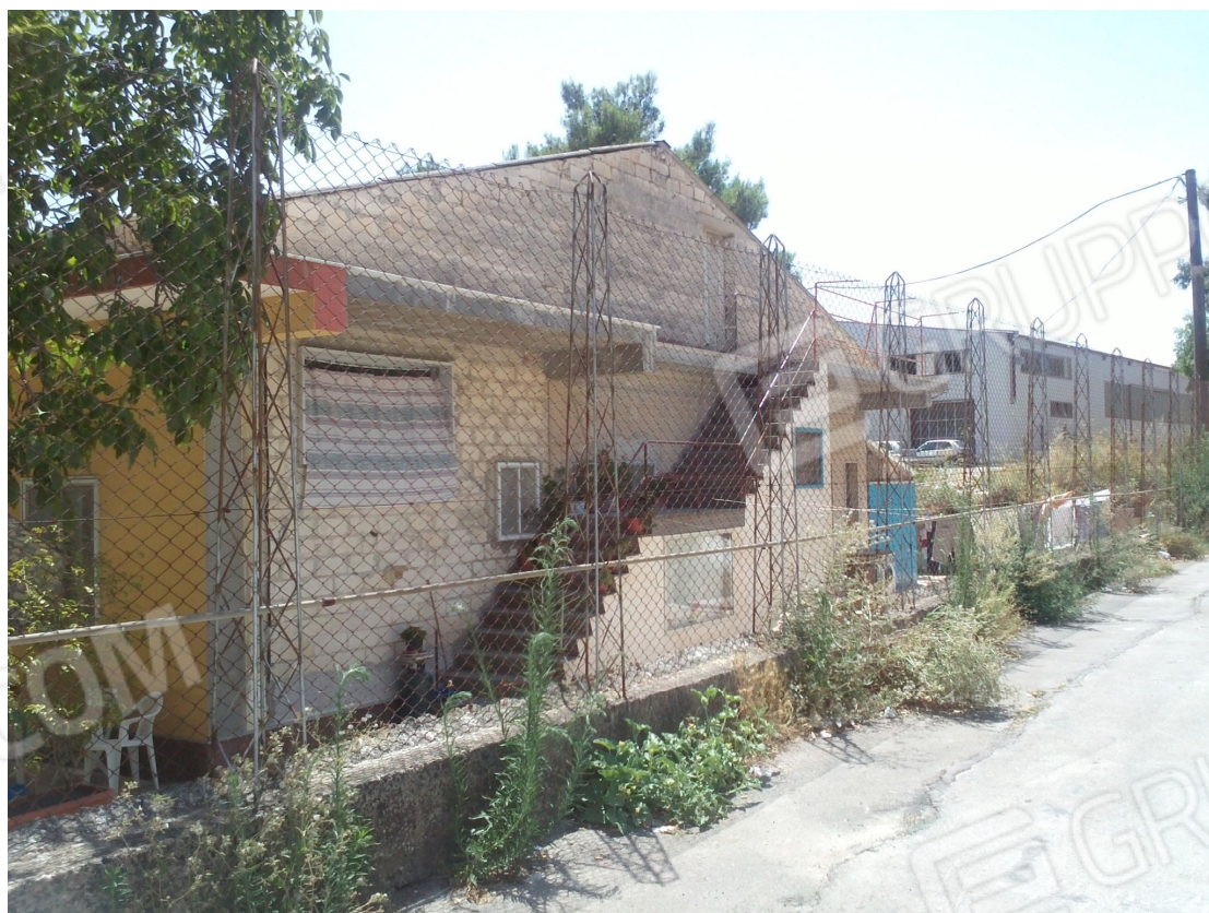
Foto 10. Muratura esterna senza intonaco al sub 8
