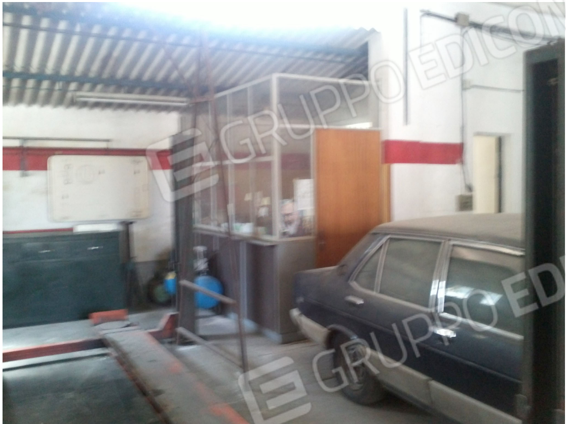
Foto 07. Ufficio in ferro e vetro con copertura in lamiera grecata.
