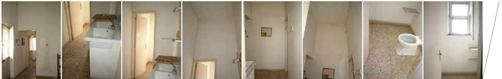
Foto da 40 a 45, vano A2 - disimpegno
