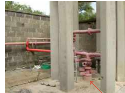
Foto 174-175-176-177 , pozzo trivellato P1e sovrastante serbatoio acqua sospeso Q
