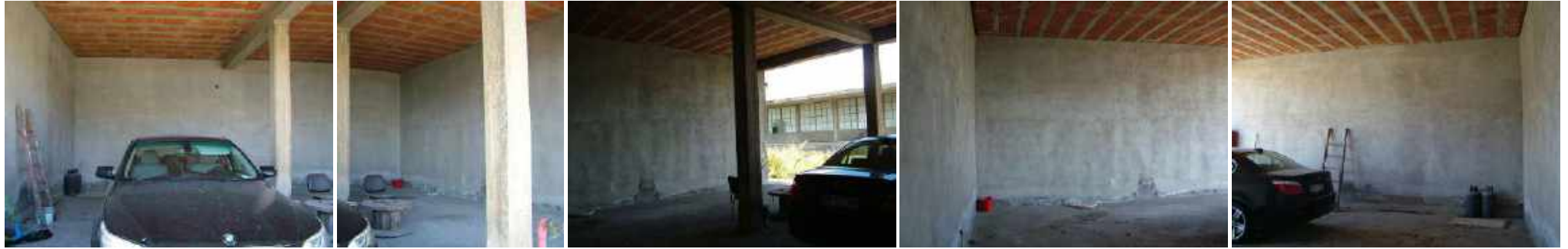
Foto da 124 a131, vano B8 - magazzino
