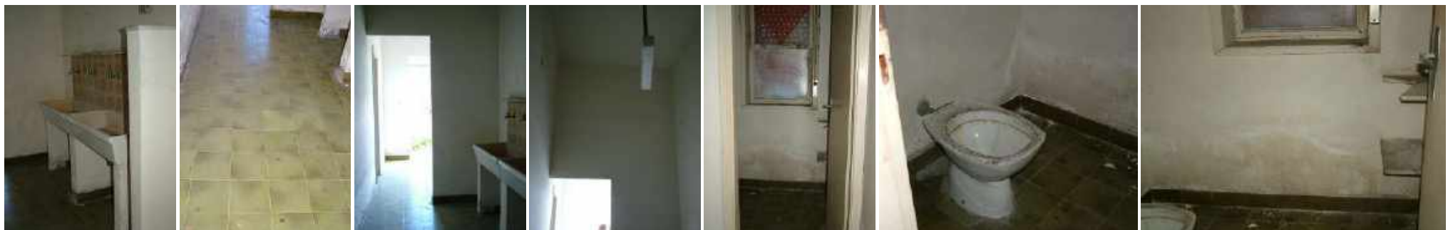
Foto 146-147-148, vano B11 - bagno
