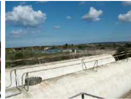
Foto 259-260, vasca di riserva idrica antincendio I
