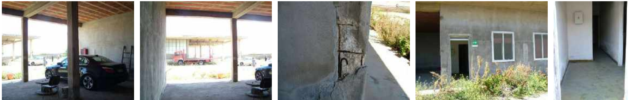
Foto da 132 a 137, vano B9 - Ingresso agli spogliatoi
