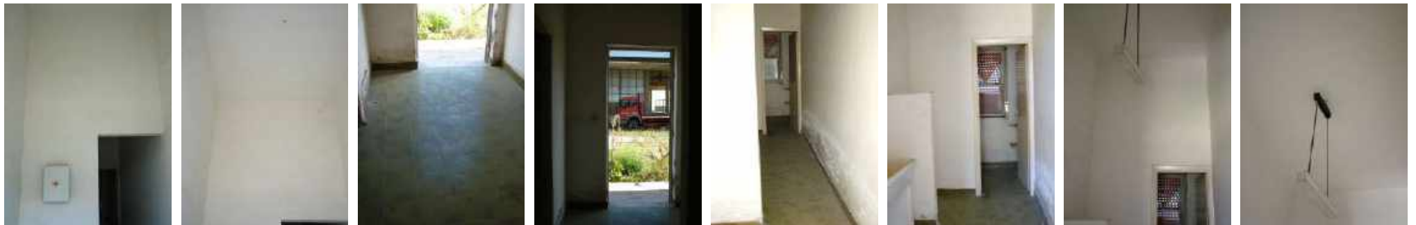
Foto da 138 a 145, vano B10 - antibagno
