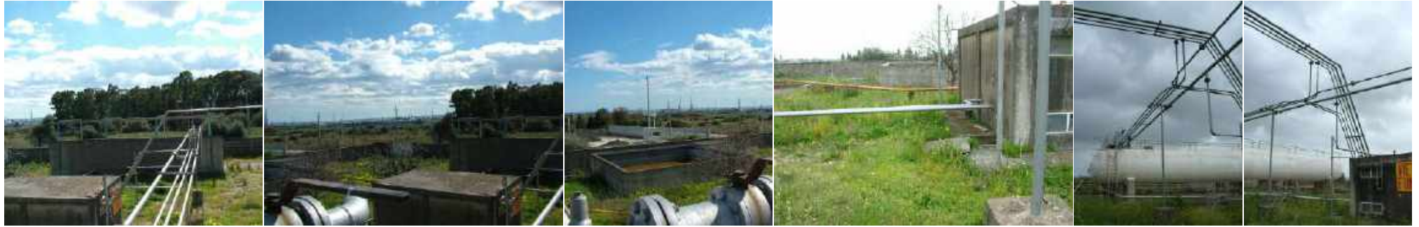
Foto 271-272-273-274, vista dai serbatoi della sala pompe e compressori GPL (immobile M), del punto di travaso (immobile N), della vasca di riserva idrica antincendio (I)
