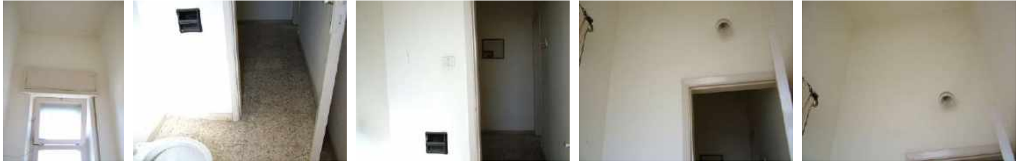
Foto da 48 a 52, vano A3 - bagno
