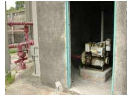
Foto 178-179-180-181-182 vano C1 - locale tecnico (pompe antincendio)
