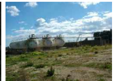
Foto 212, Immobile G (serbatoi/sigari)
