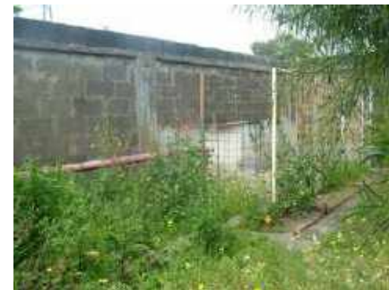
Foto 317-318-319-320, confine sud - punto O di attacco motopompa W FF
