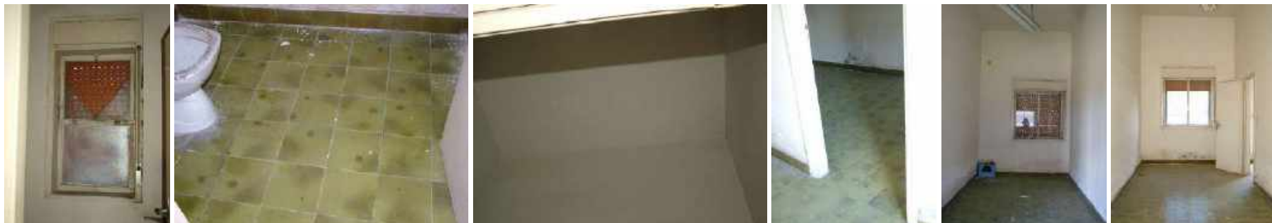
Foto 149,150, 151 vano B11 - bagno
