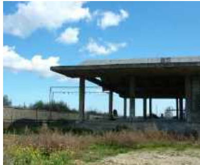
Foto 199-200-201 immobile F (capannone a ribalta)
