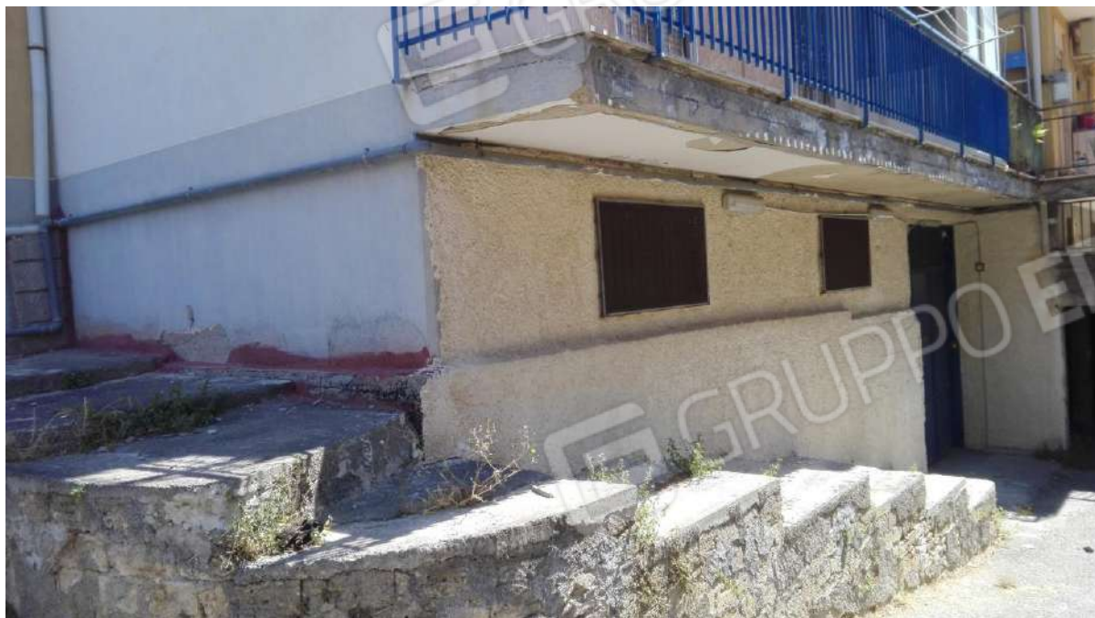
Foto 1 – Visione scivolo e ingresso lato esterno
