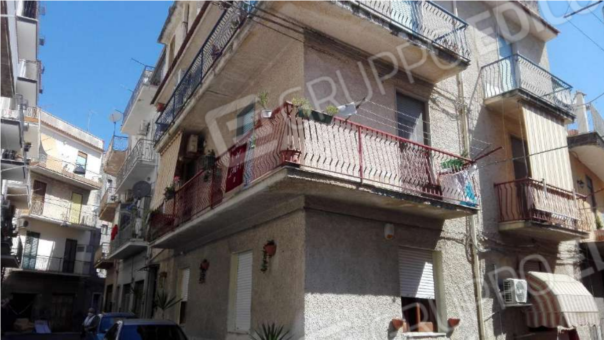
Foto 4 – Visione assometrica esterna dei due prospetti
