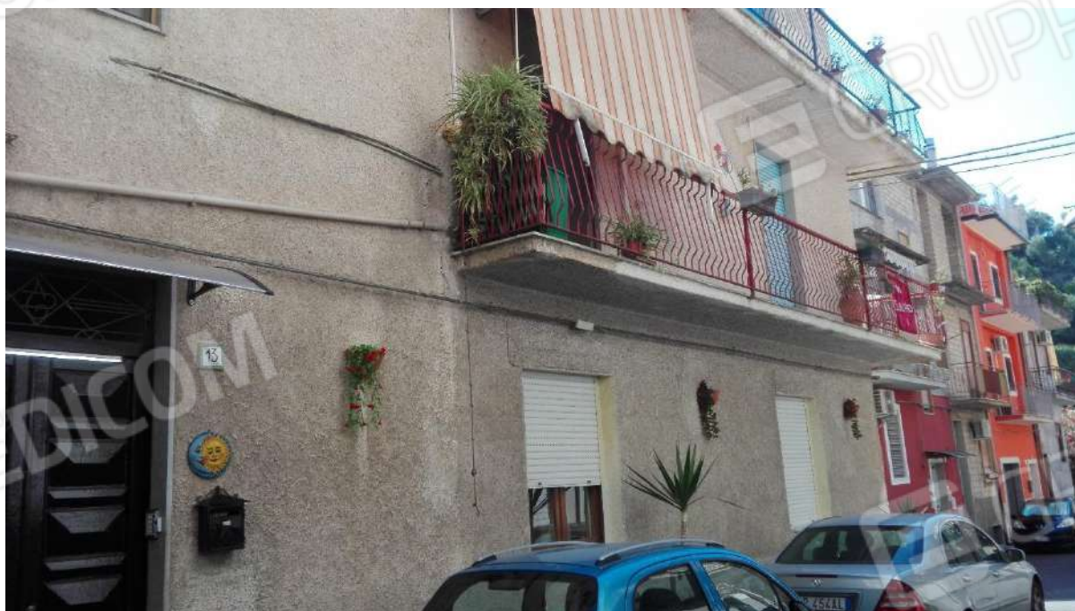
Foto 2 – Visione Prospetto su Via Legnano
