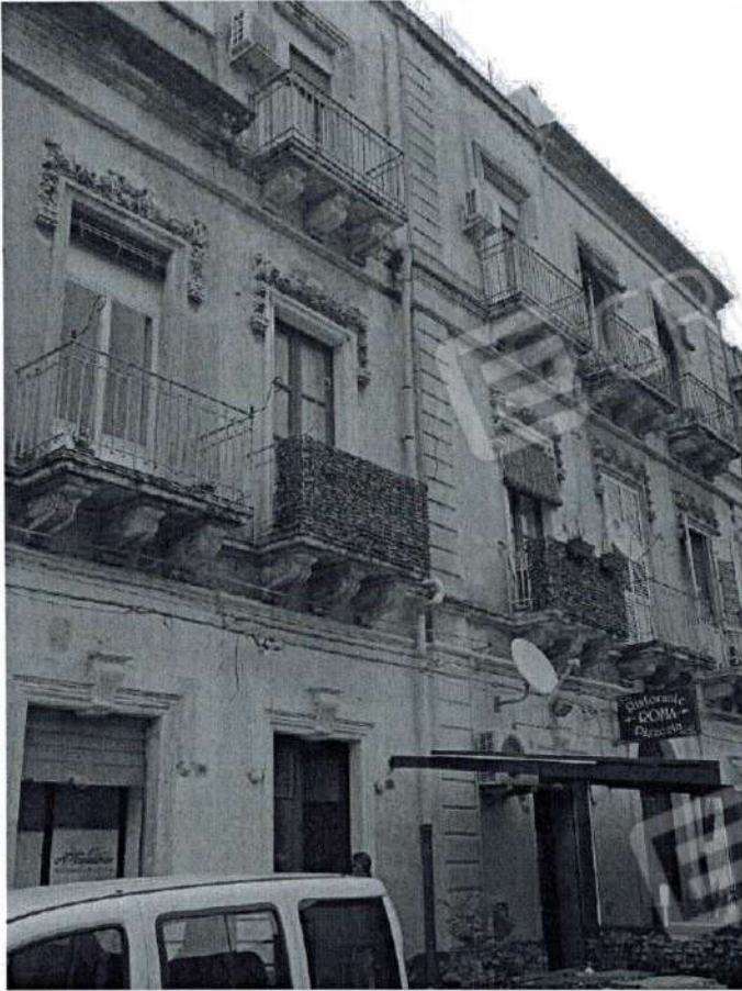
01: Prospetto su via Roma
