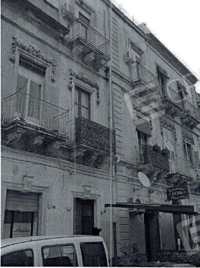
01: Prospetto su via Roma
