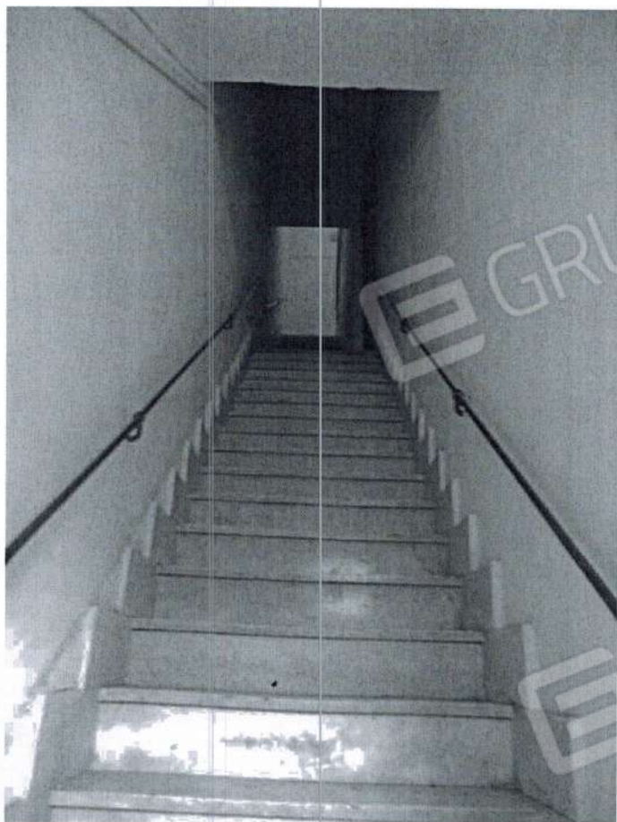
03: Rampa Scala di collegamento P. terra/P.1°
