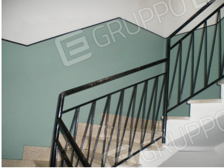
PARTICOLARE DEL VANO SCALA
