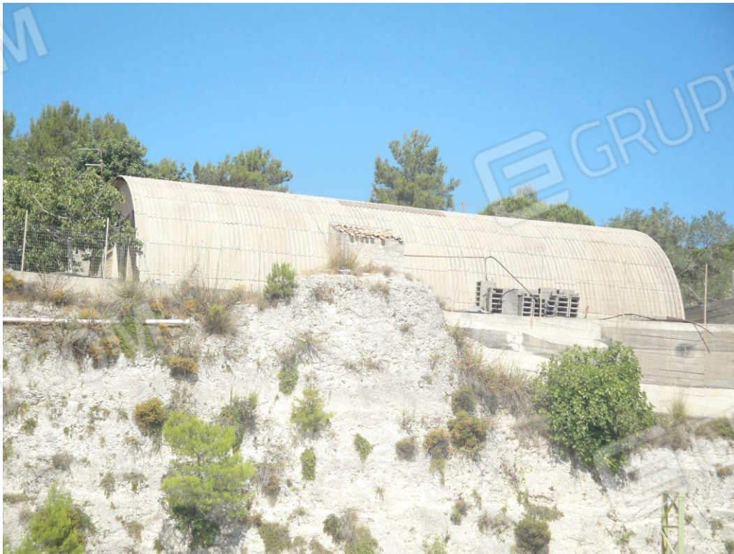
Foto_08 veduta esterna del capannone
