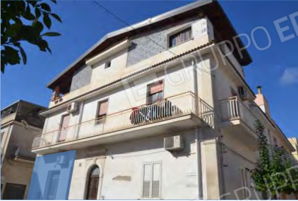
Fot.n°13: prospetto principale, vista ad angolo Via Capitano Cultrera e Via Sipione
