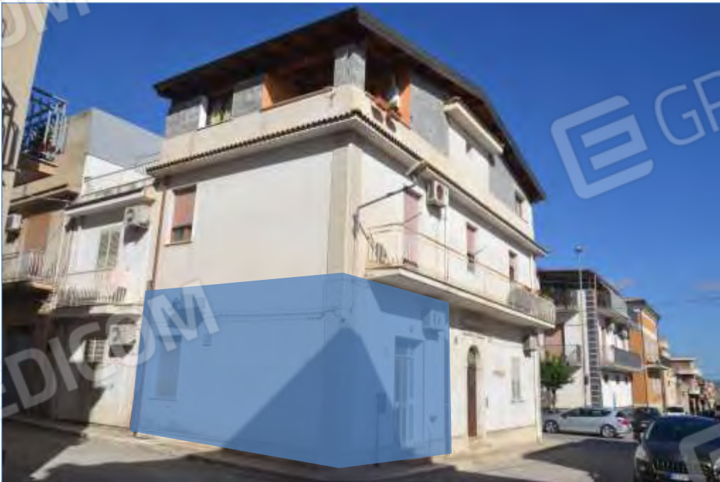
Fot.n°16: vista generale
