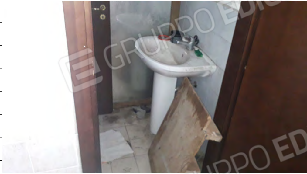
Foto n.13: immagine interna dell'anti wc ubicato al piano terra.
