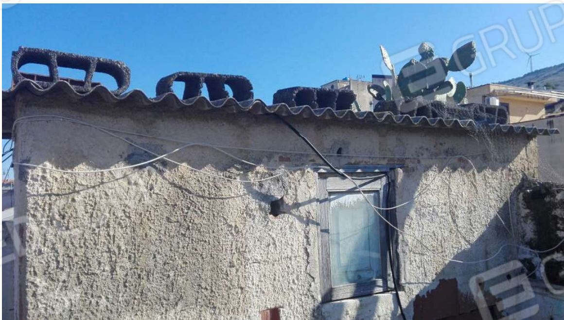
G.26 – G.27 – G.28 -- Vedute di altre parti della copertura, particolare del locale di sgombero.
