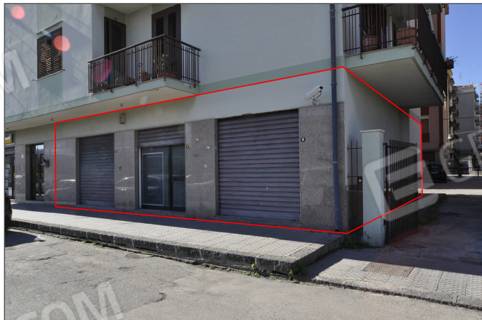
FOTO 1 - Vista esterna Unità Immobiliare -
