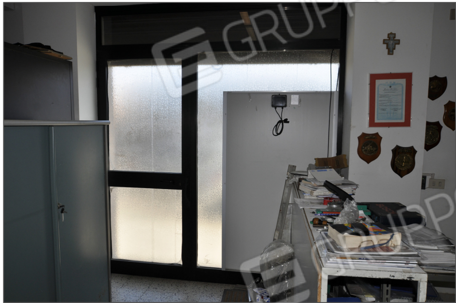
FOTO 3 - Vista interna Unità Immobiliare -
