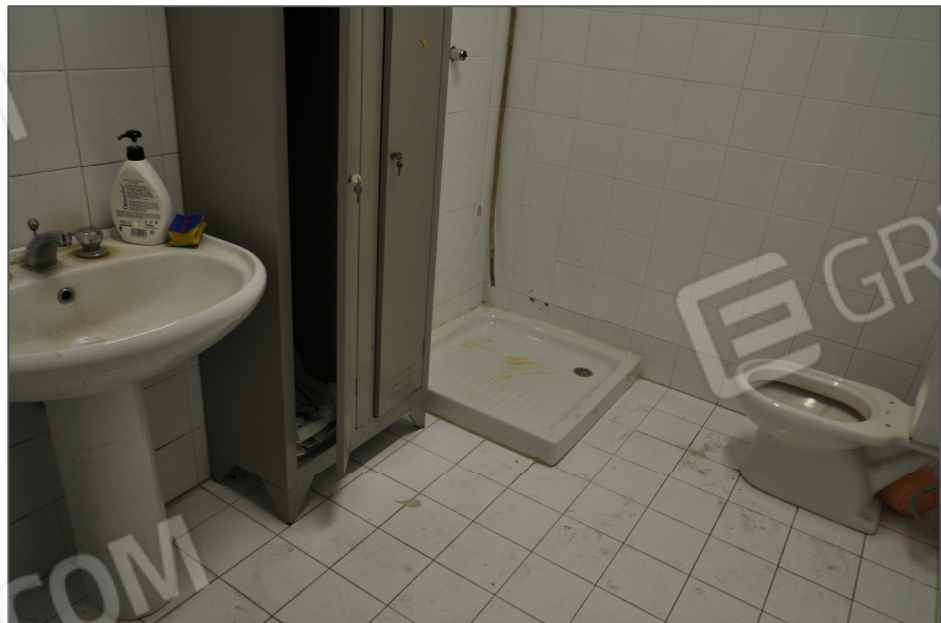
FOTO 10 - Vista interna Unità Immobiliare -
