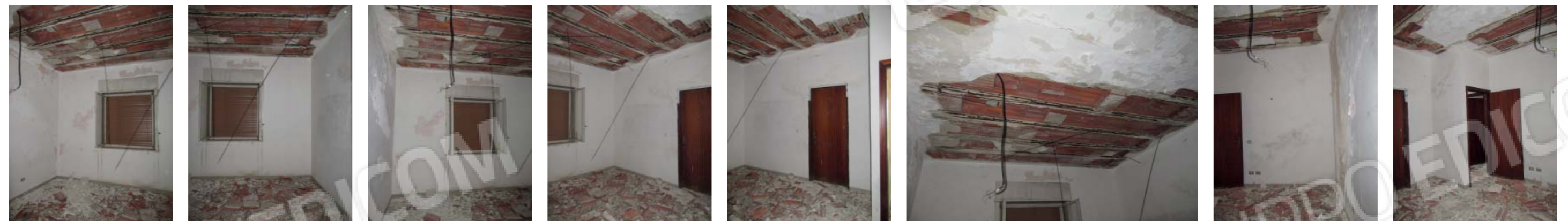
Foto da 141 a 148 , vano A7
