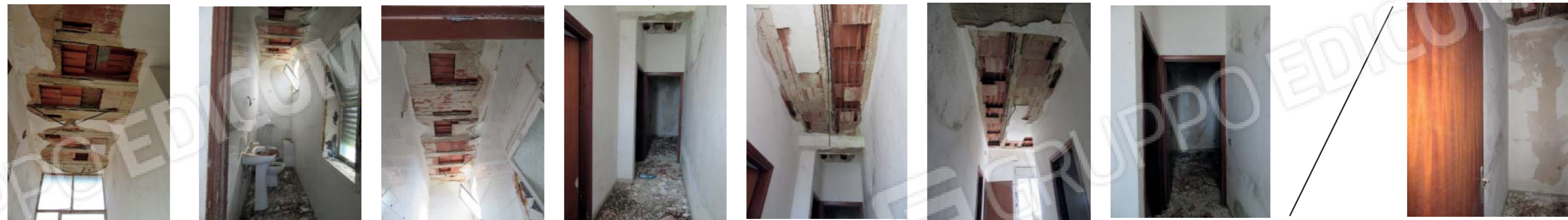
Foto 134 vano A1, Foto 135-136 vano A2
