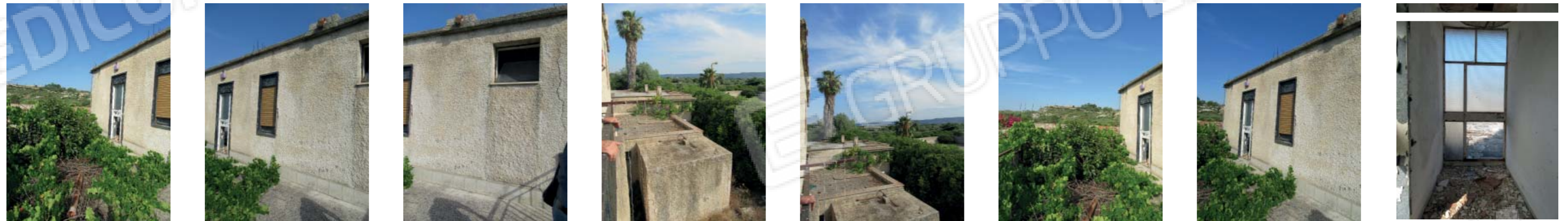
Foto da 127 a 132 - facciata immobile a sud-est
