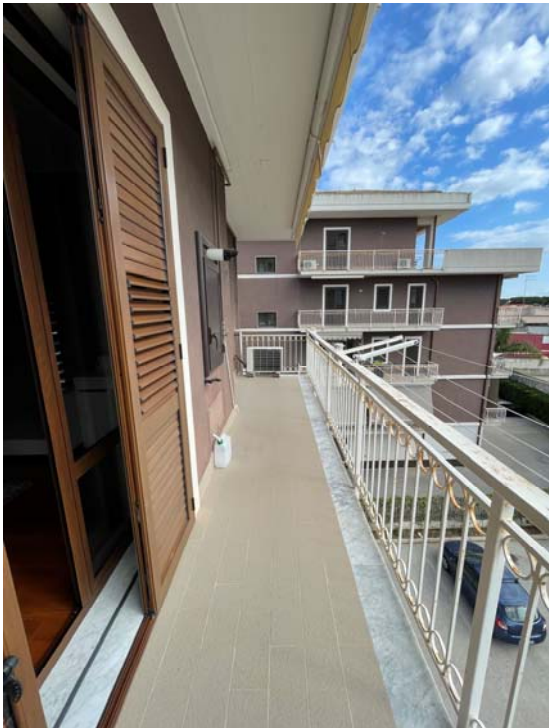
Vista del balcone 02 (lato salotto)
