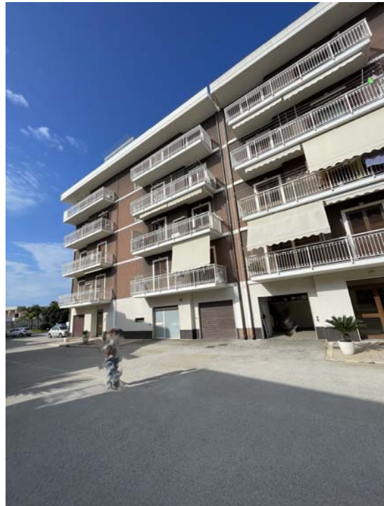
Vista del fabbricato
