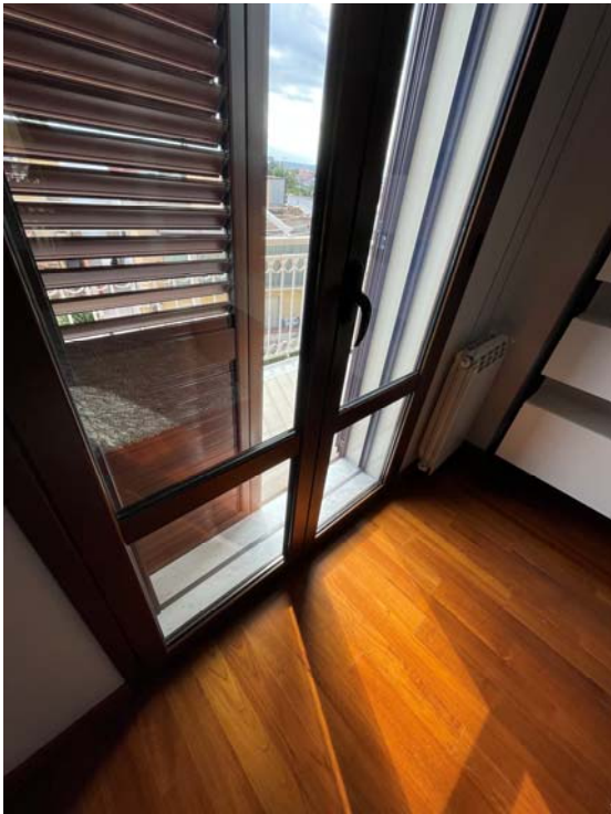
Dettaglio fotografico degli infissi esterni
