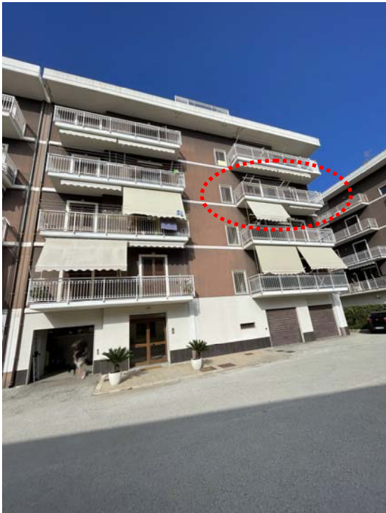
Vista del fabbricato e individuazione dell'immobile
