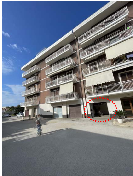
Vista del fabbricato
