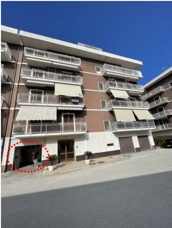
Vista del fabbricato e individuazione dell'immobile
