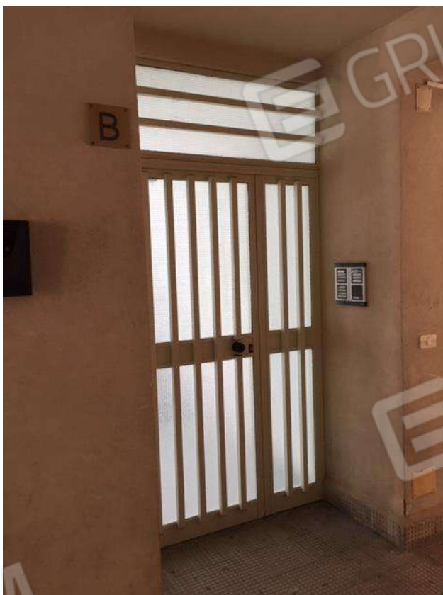
Foto 13. Portone di ingresso all'edificio scala B.
