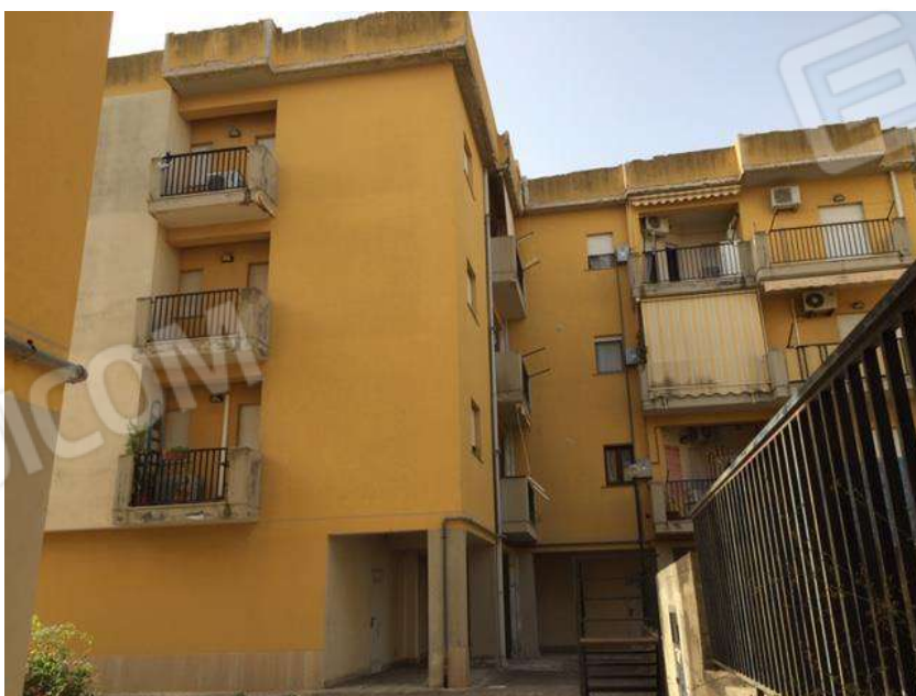
Foto 10. Prospetto su corte comune.
