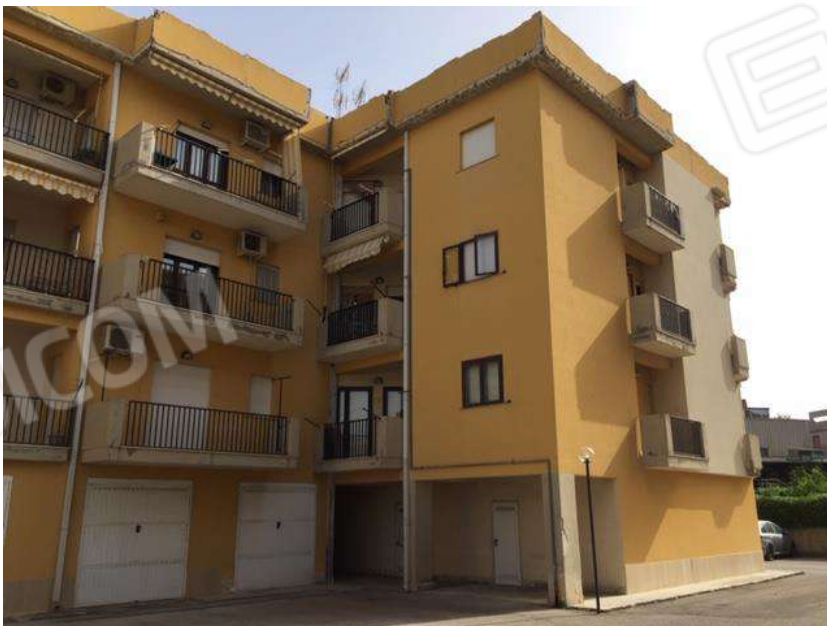
Foto 8. Prospetto su corte comune.
