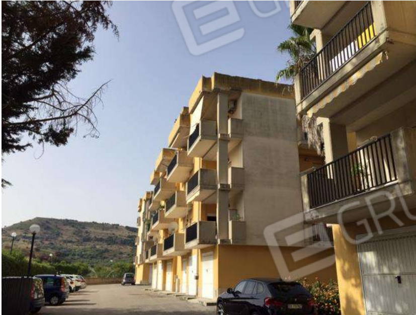
Foto 7. Prospetto su corte comune.
