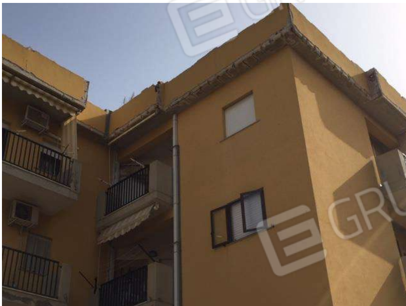
Foto 9. Dettaglio prospetto su corte comune.
