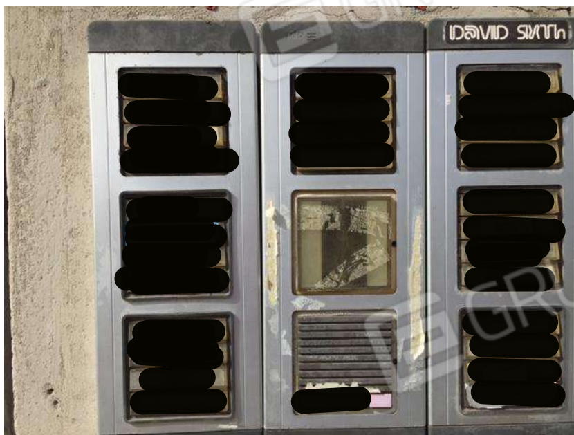
Foto 5. Citofono del complesso residenziale.
