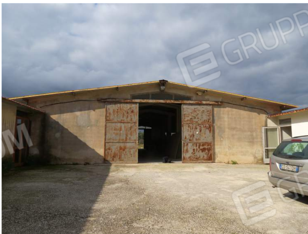
Foto n. 6: Prospetto anteriore corpo 1
