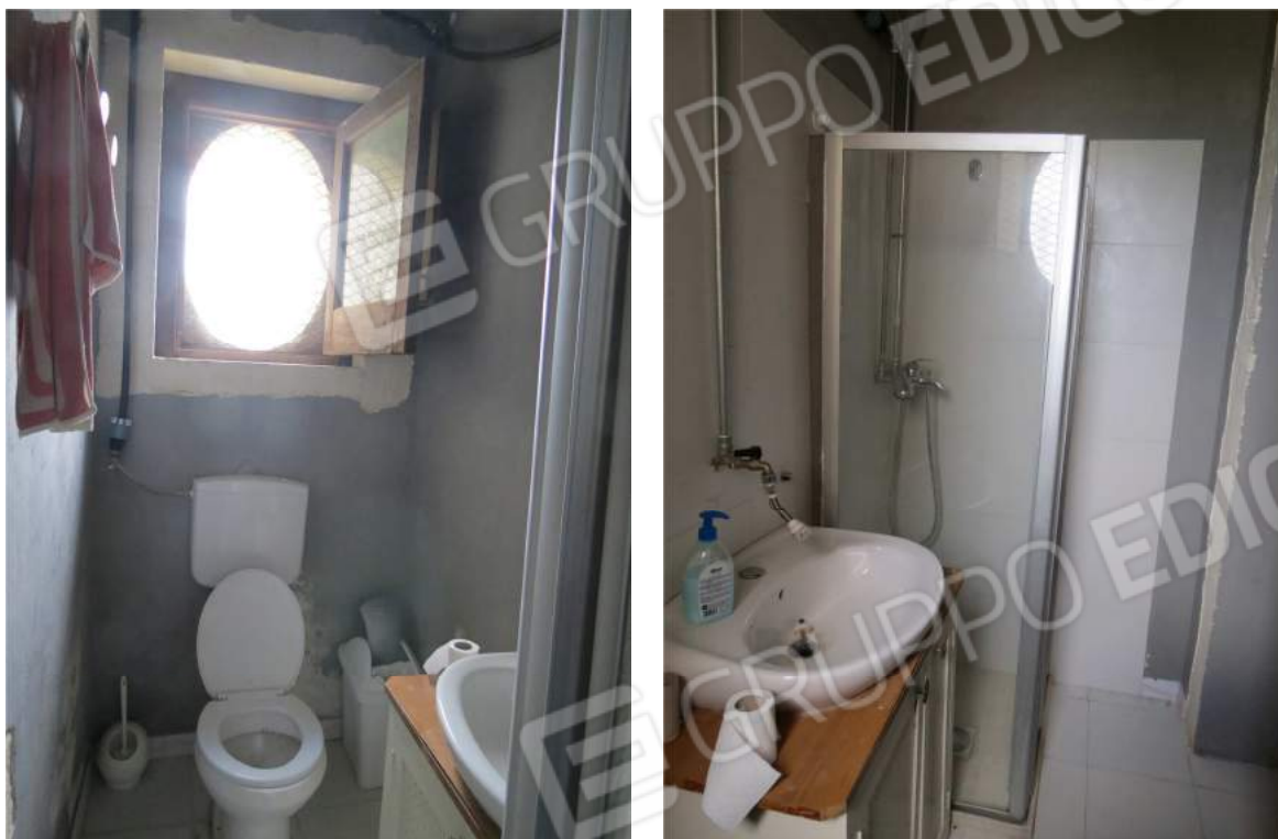
Foto n. 21: Interno corpo 3 (vano WC)
