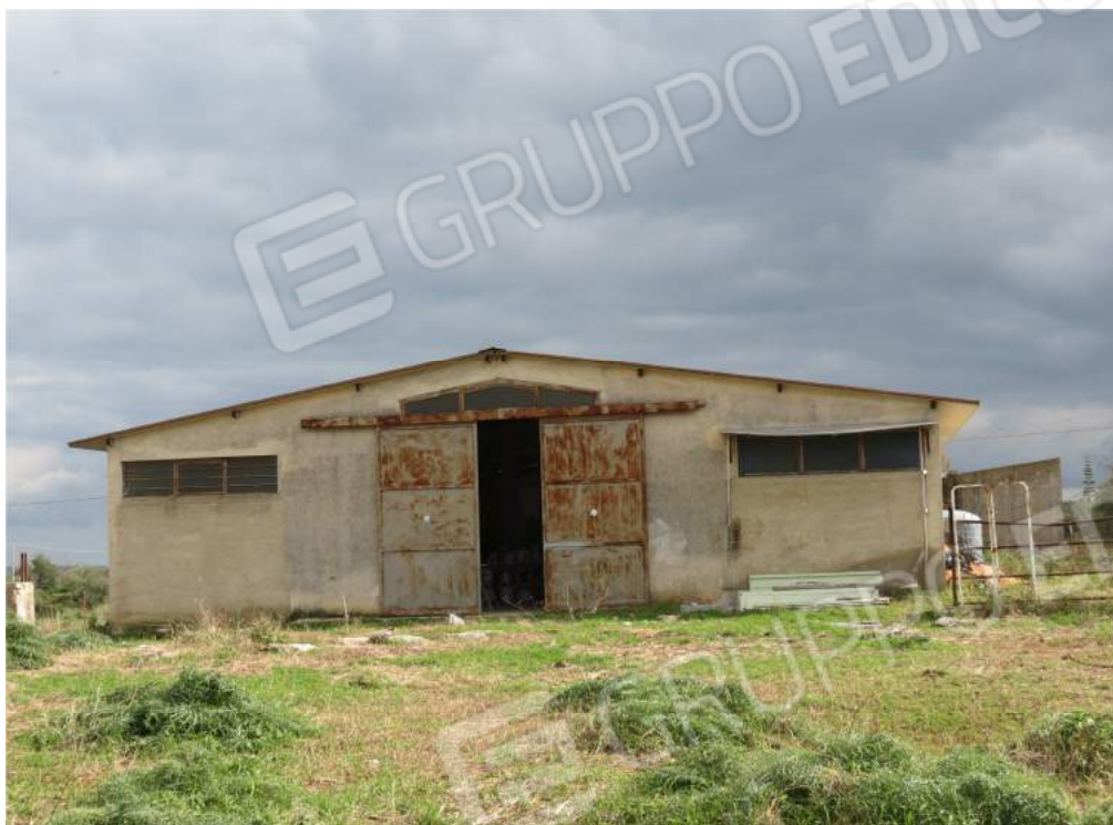
Foto n. 7: Prospetto posteriore corpo 1
