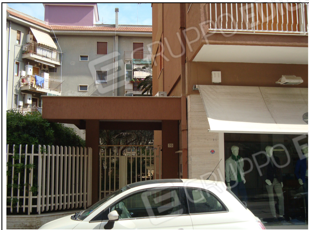
FOTO 1. Vista del cancello pedonale di ingresso al numero civico 70 di via Sen. Di Giovanni
