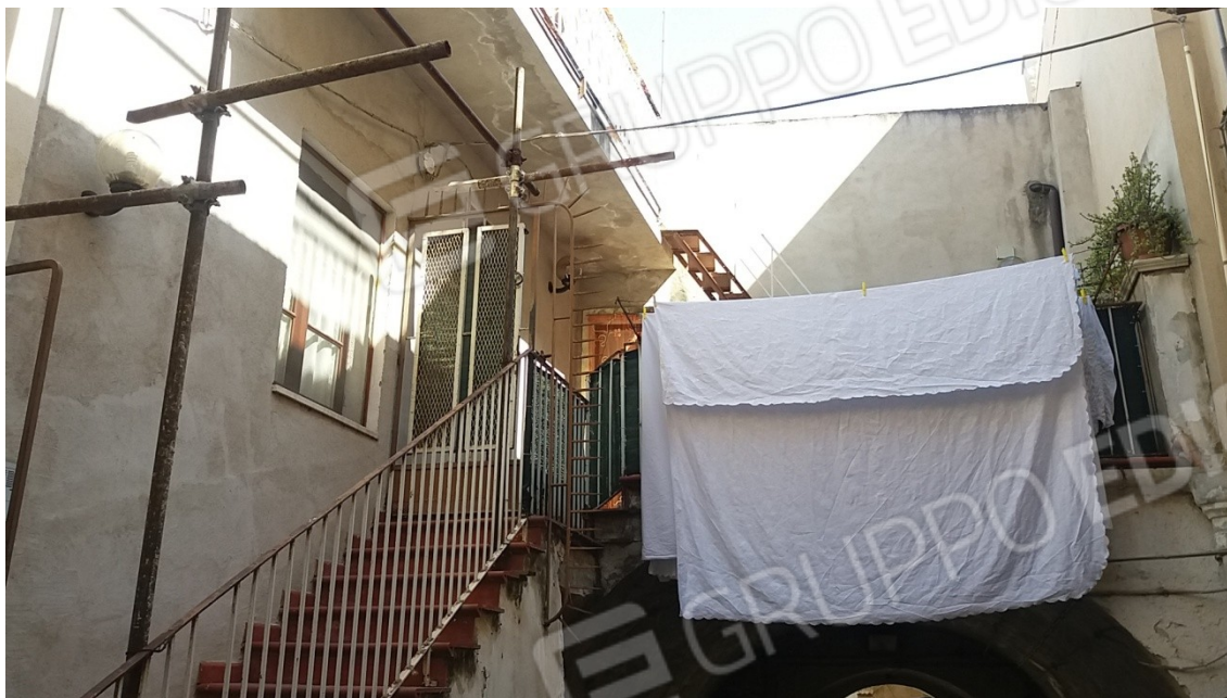
6_Scala d'ingresso sul prospetto sud
