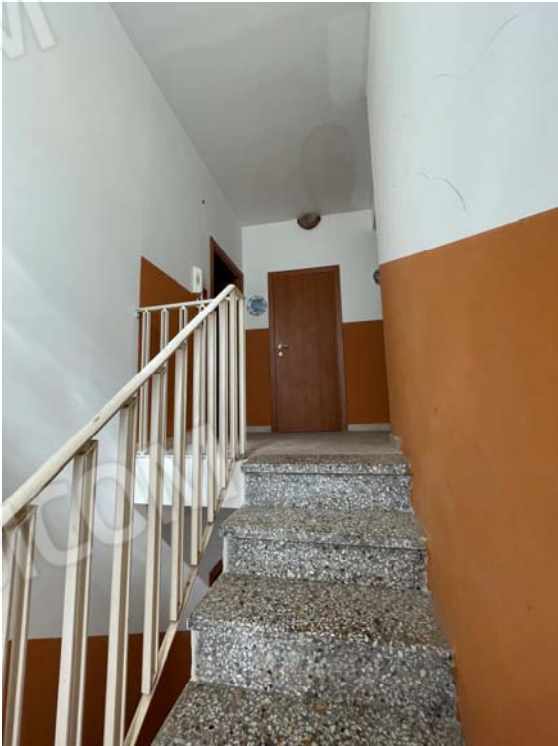
Vista della scala interna in corrispondenza dell'ingresso
