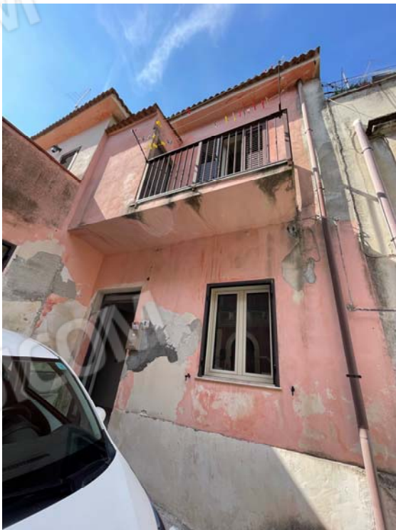
Vista esterna dell'immobile
