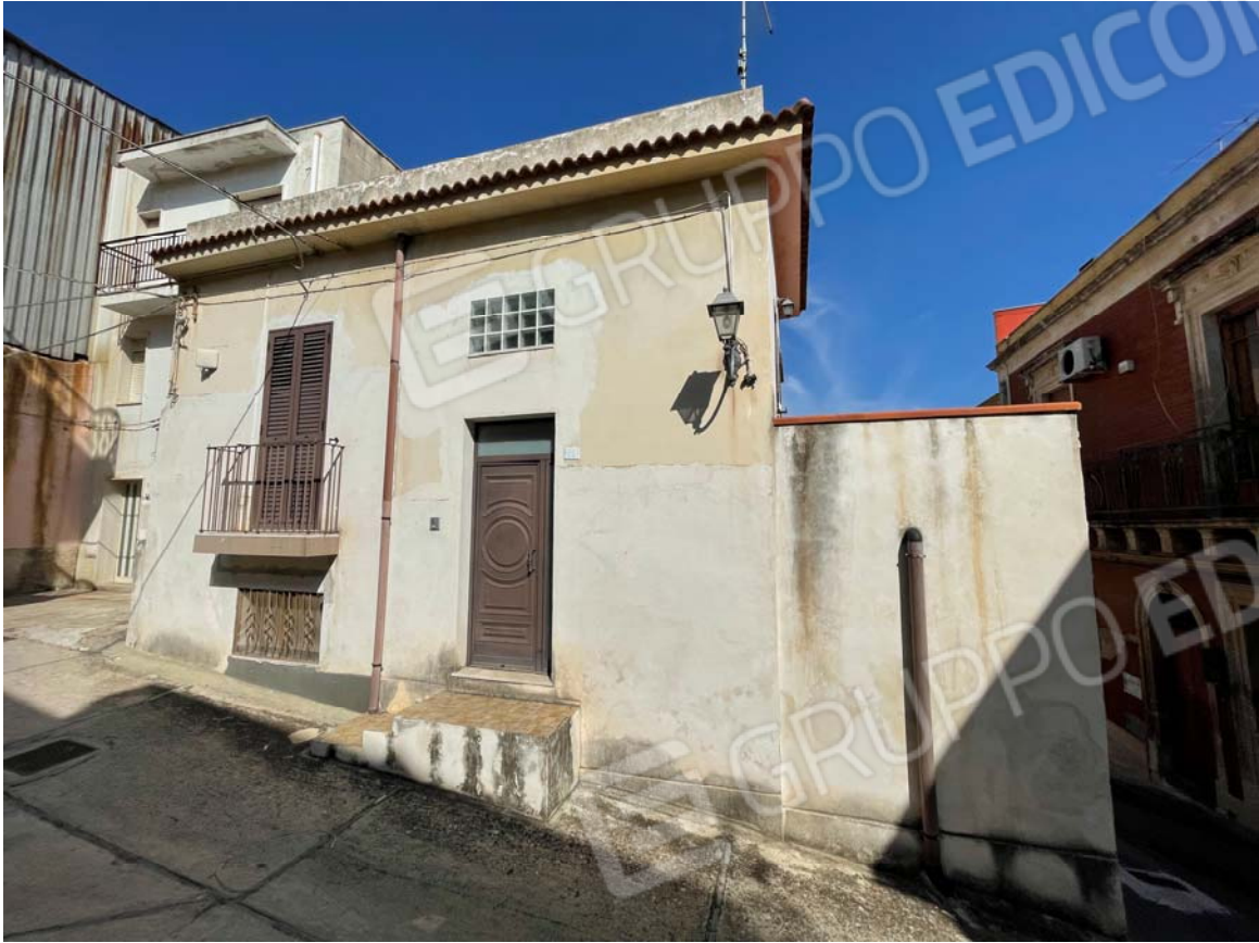
Vista esterna dell'immobile
