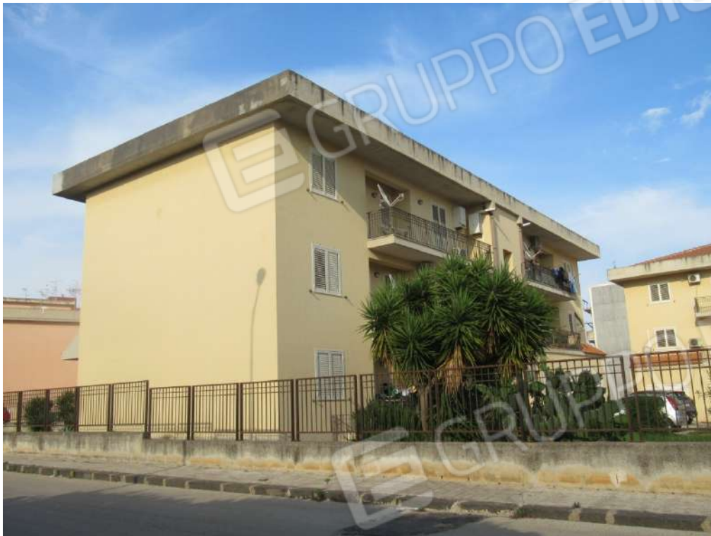
Foto 5_ Prospetto stabile laterale
