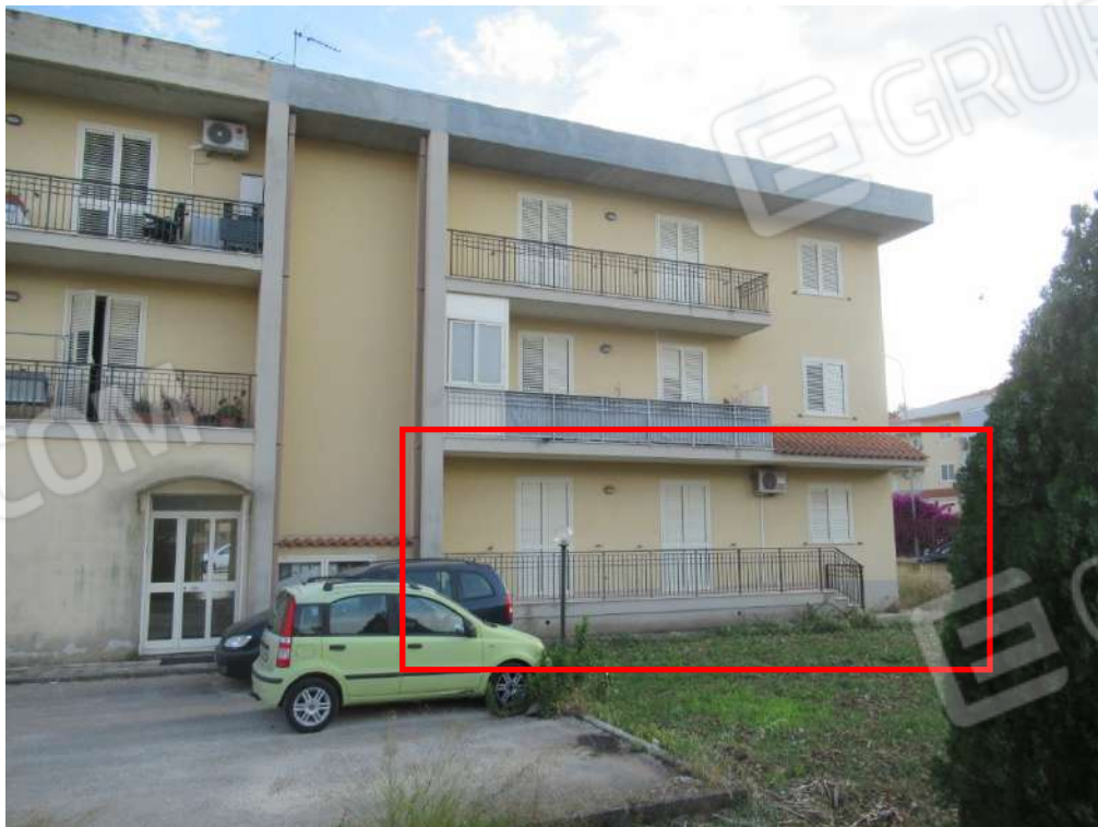
Foto 4_ Prospetto stabile su Via Mariano Pinnone
