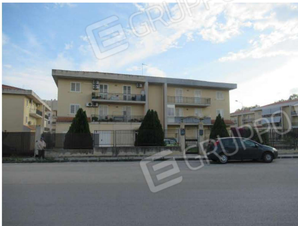
Foto 1_ Prospetto stabile su Via Mariano Pinnone
