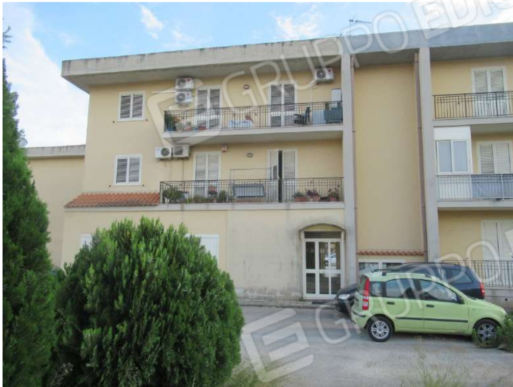
Foto 3_ Prospetto stabile su Via Mariano Pinnone
