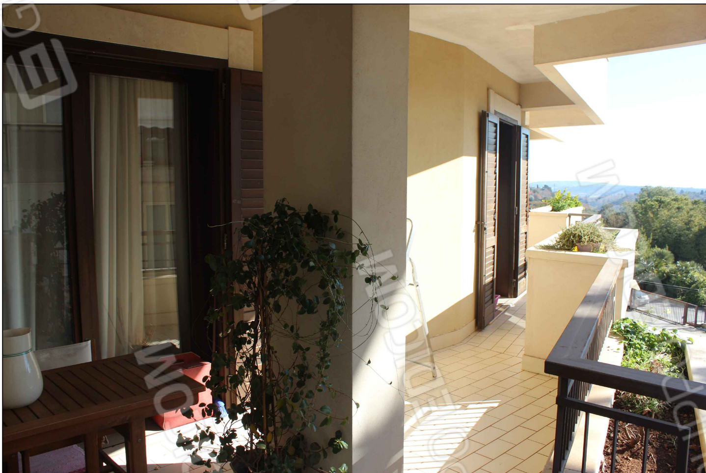
N.16 Vista da Veranda lato Sud.
