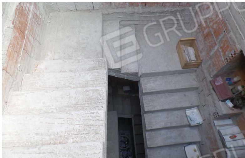
Foto n° 21. Piano 2°: Vano scala
