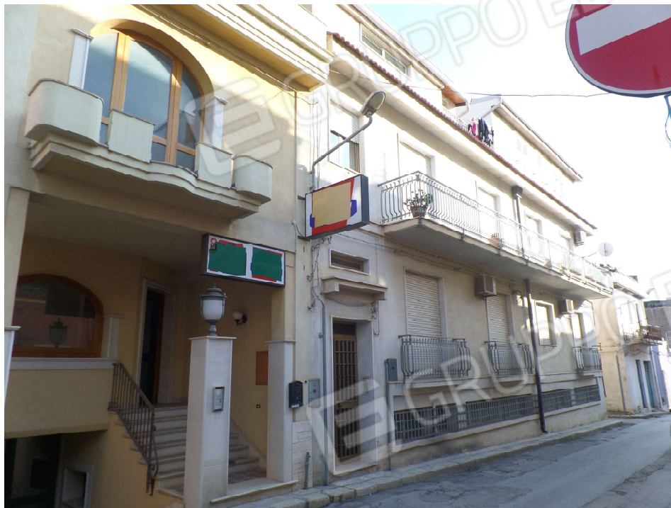
Foto n° 23. Rosolini: Prospetto Via Dante Alighieri
