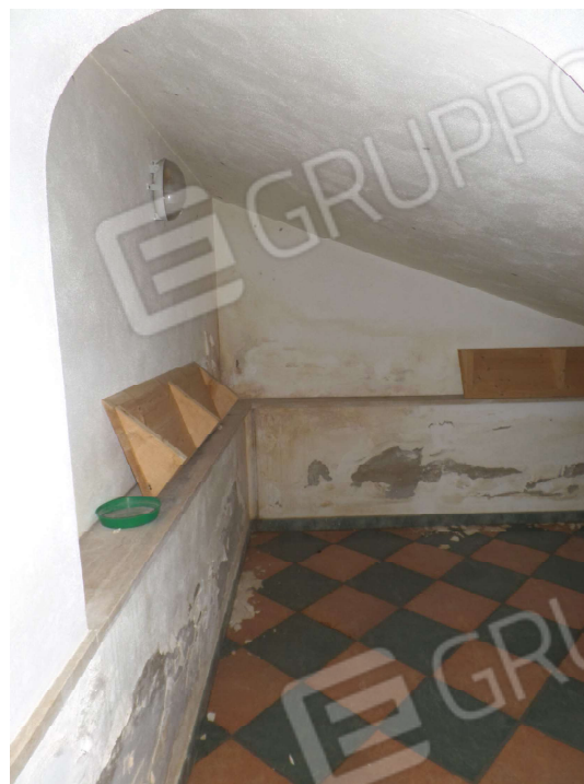
Foto n° 6. Piano Seminterrato: sottorampa
