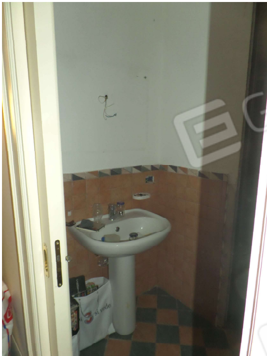
Foto n° 10. Piano Rialzato: Antibagno
