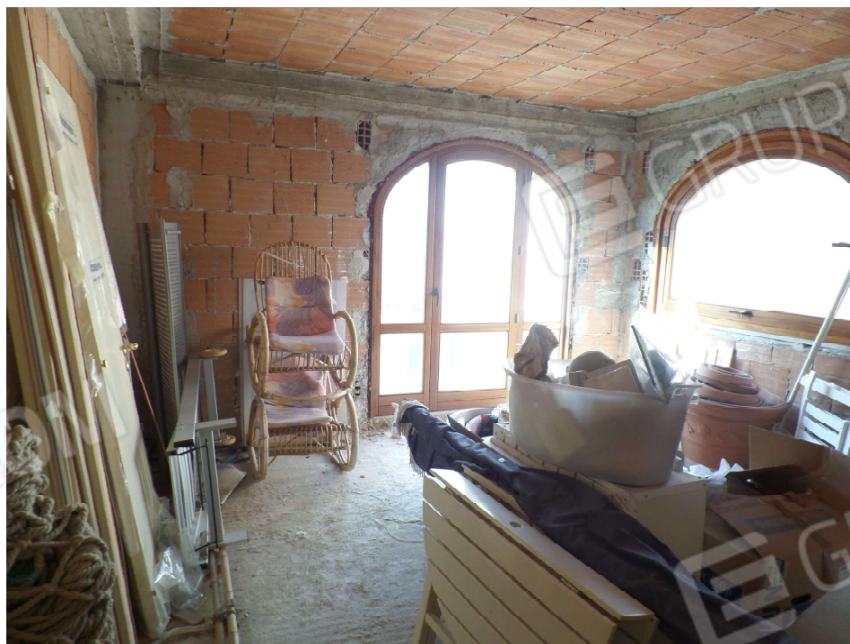
Foto n° 16. Piano 1°: Vano 4/Soggiorno/Pranzo
