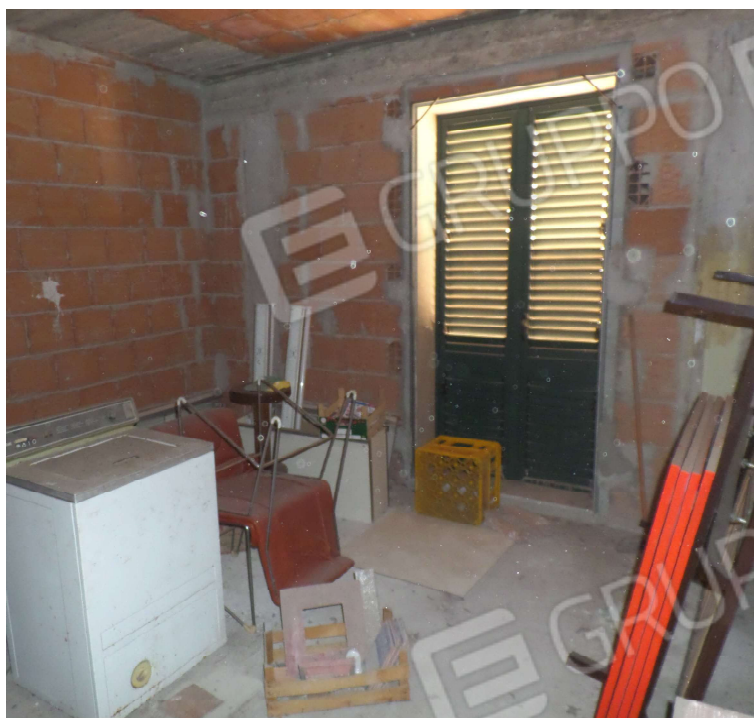
Foto n° 13. Piano 1°: Vano 3/Cucina
