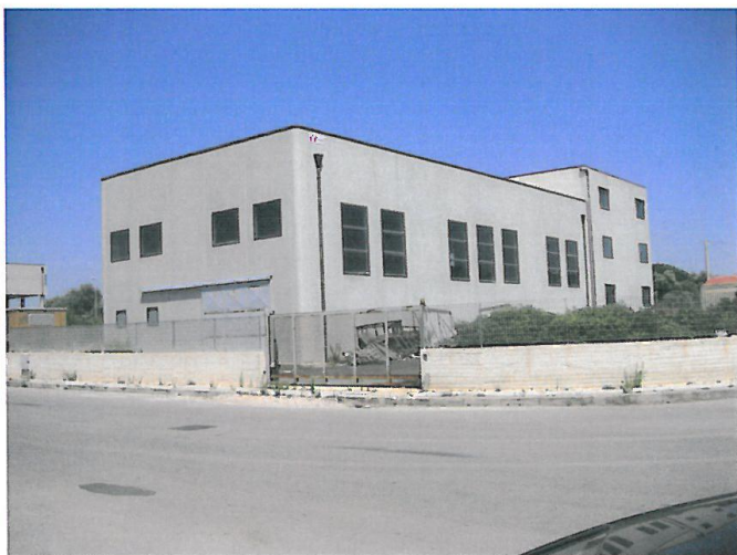
FOTO N° 12 - BENE N° 2 L'OPIFICIO TIPOGRAFICO VISTO DALLA STRADA INTERNA ALLA ZONA ARTIGIANALE
