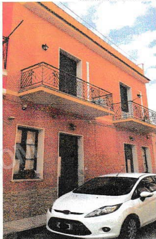
FOTO 2 FRONTE PROSPICIENTE LA VIA
