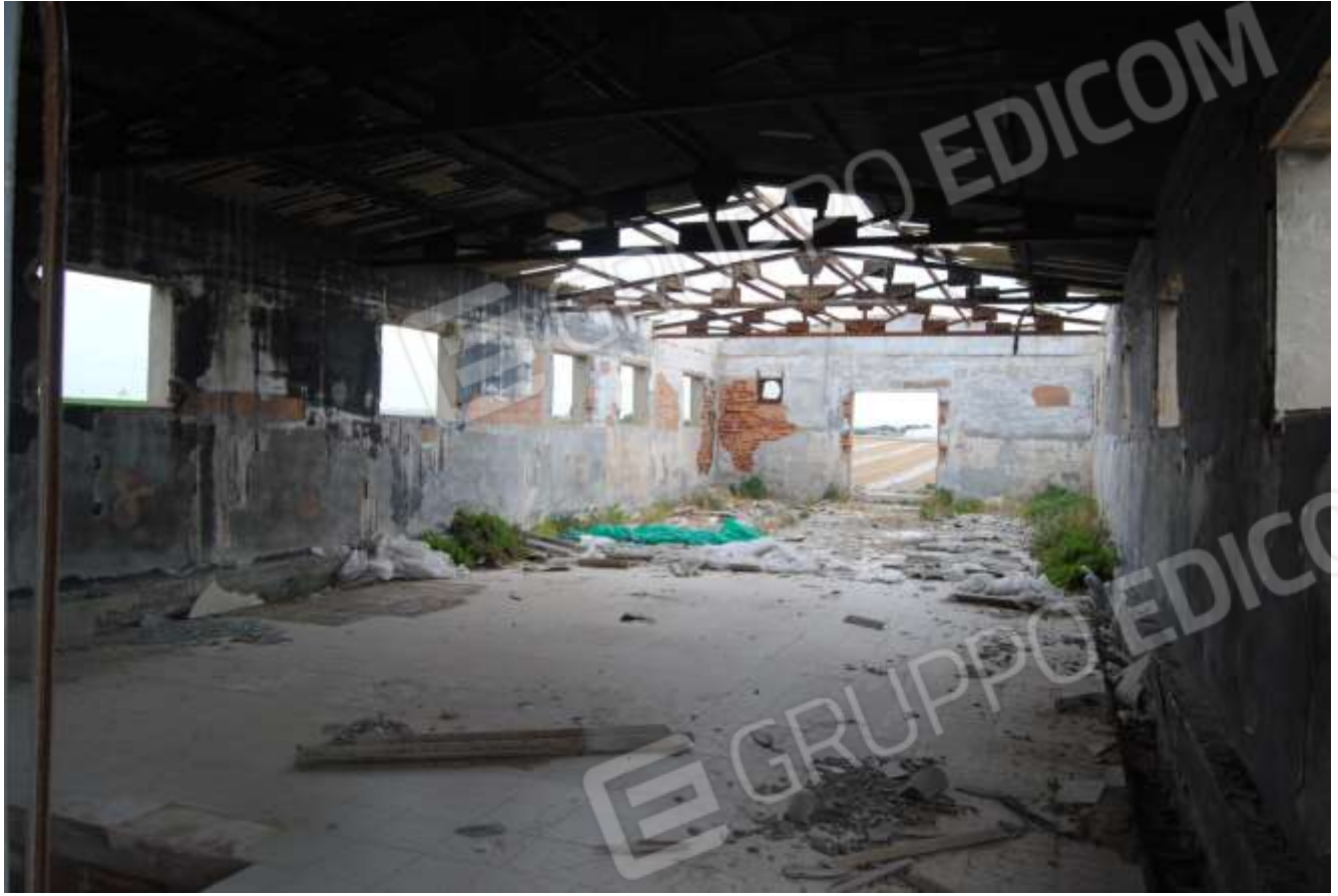
Foto n.21: Vista generale interna – Magazzino.
