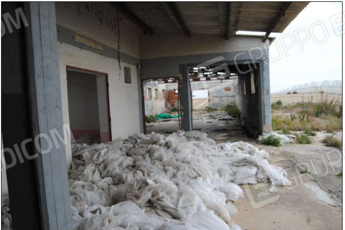
Foto n.20: Vista generale interna – Magazzino.
