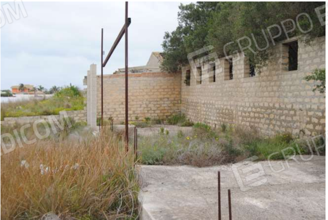
Foto n.24: Vista generale esterna.
