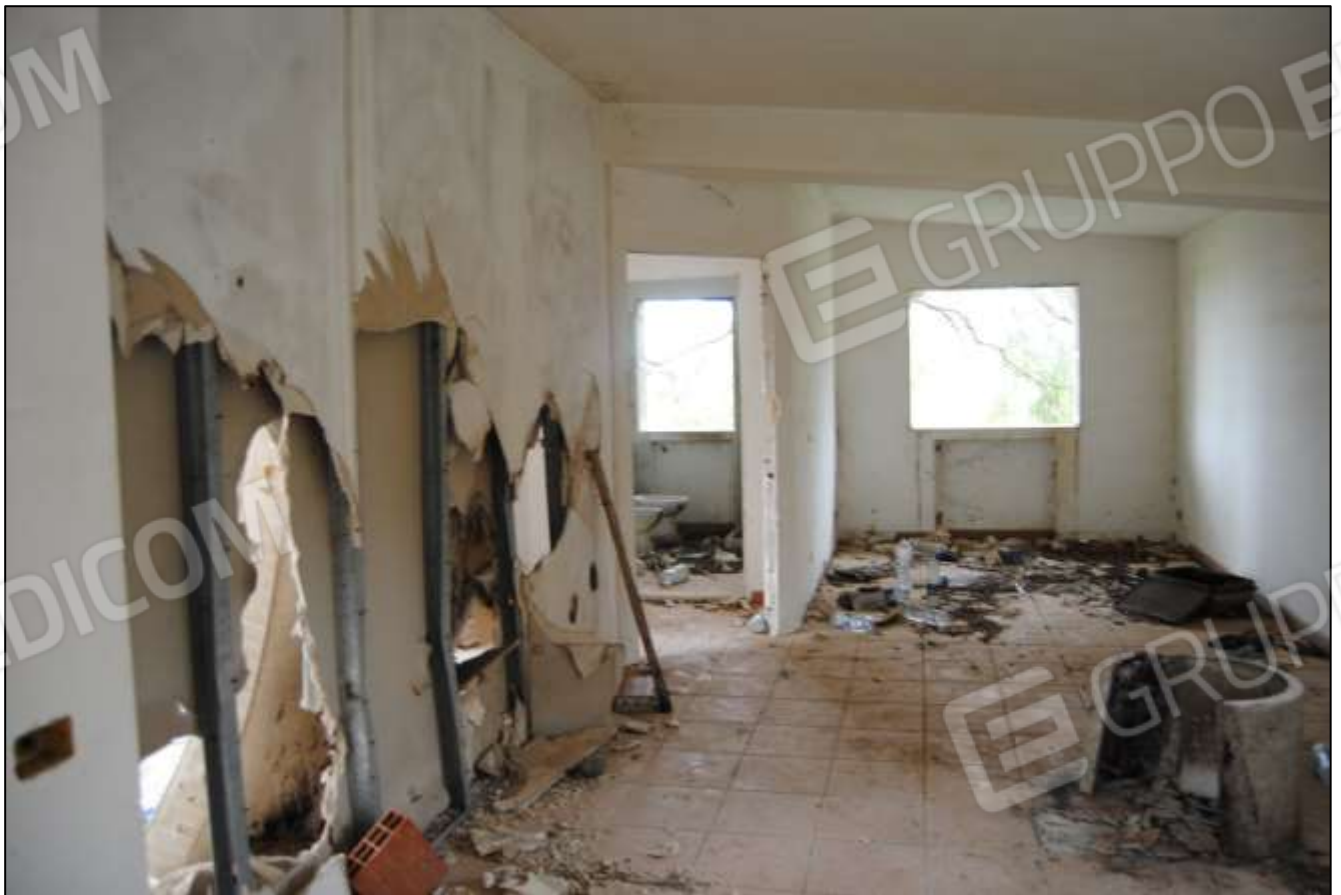
Foto n.12: Vista generale interna – Abitazione
