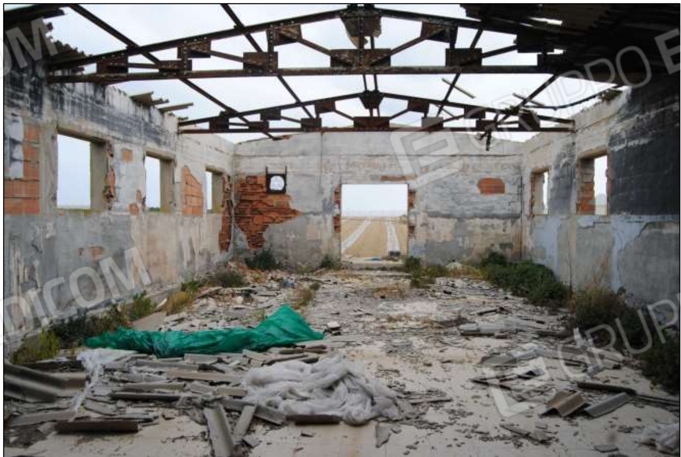
Foto n.22: Vista generale interna – Magazzino.
