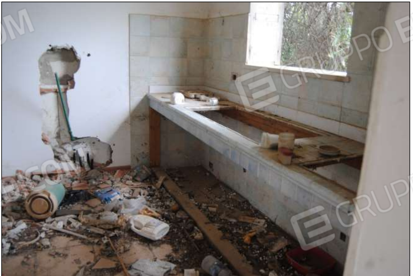
Foto n.10: Vista generale interna – Abitazione.
