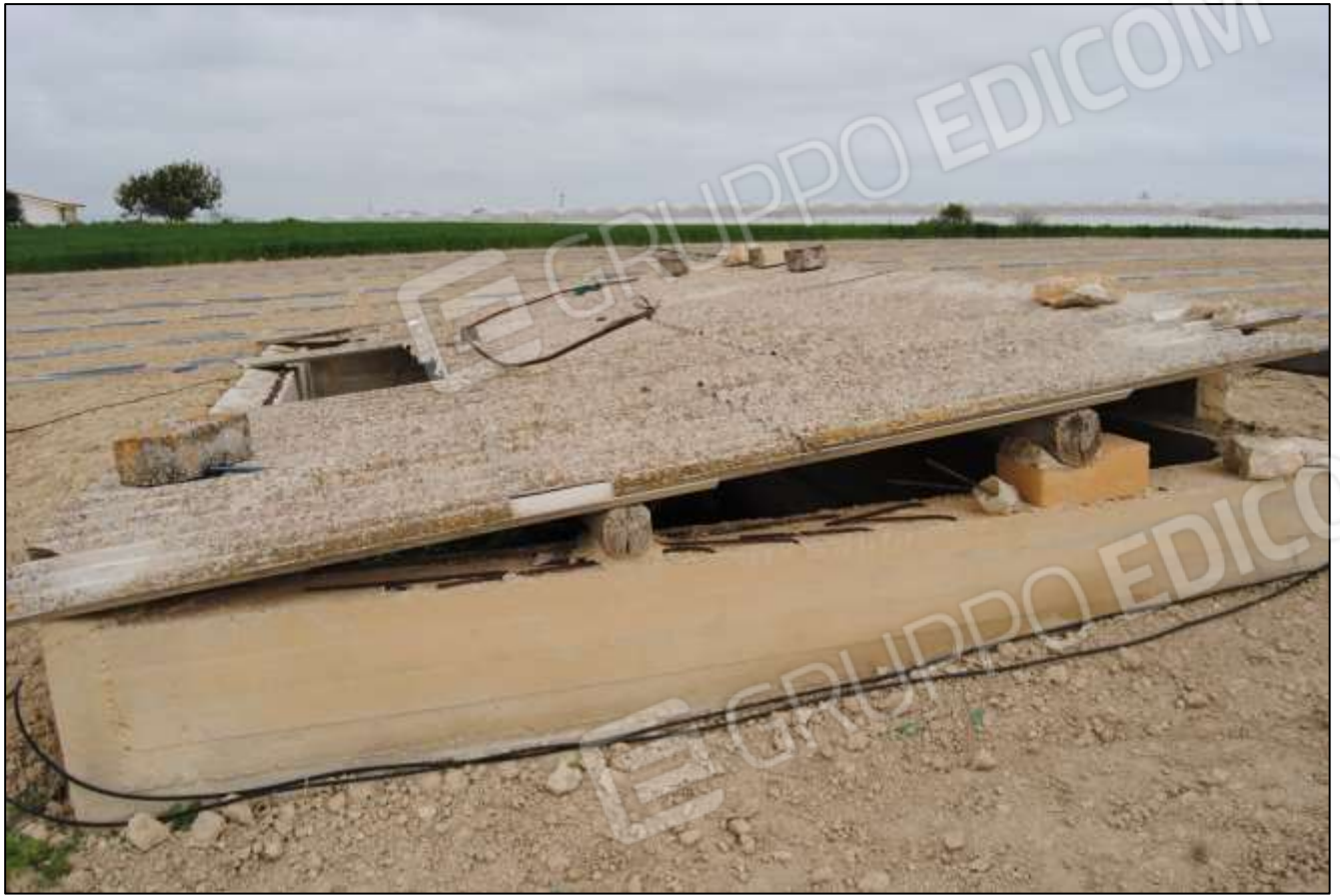
Foto n.23: Vista generale interna – Concimaia.
