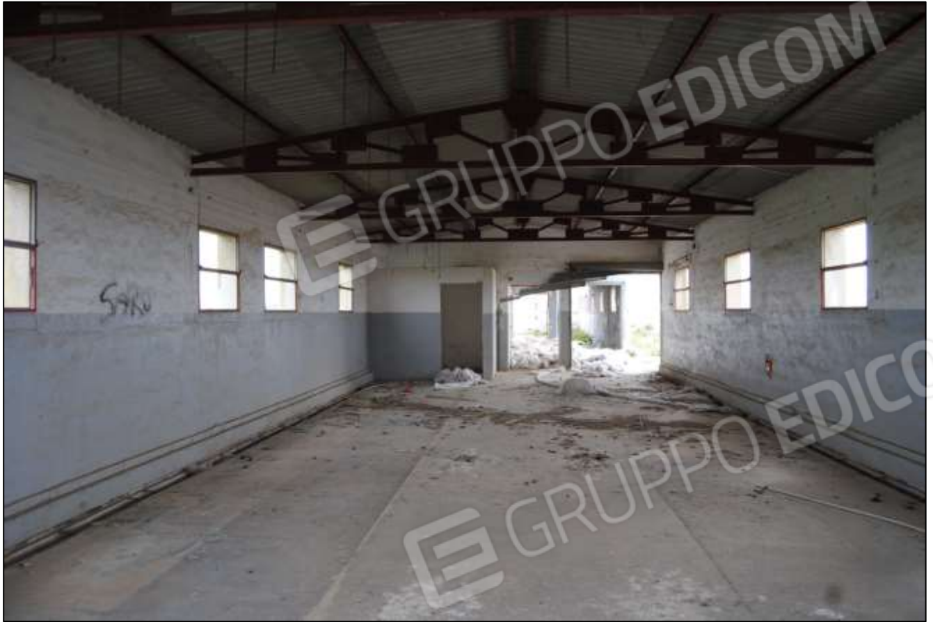
Foto n.19: Vista generale interna – Magazzino.
