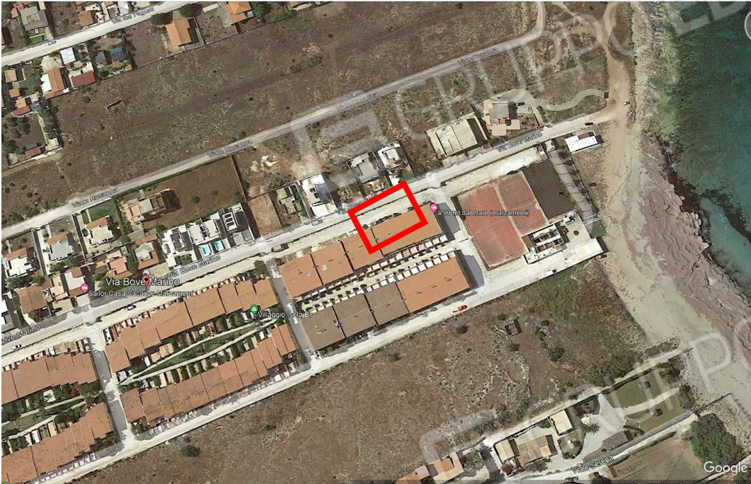
Foto 1: Aerofoto, con indicazione della struttura di cui fa parte l'immobile oggetto di stima.
