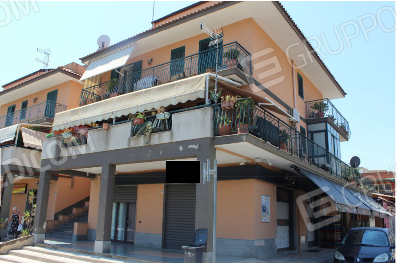
Foto n. 4 – Vista fabbricato in condominio
