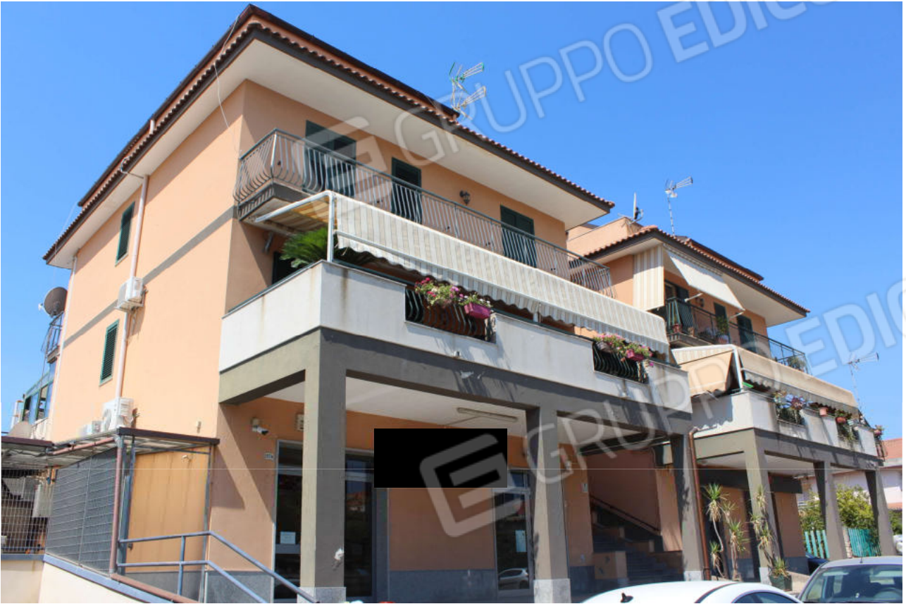
Foto n. 1 – Vista fabbricato in condominio
