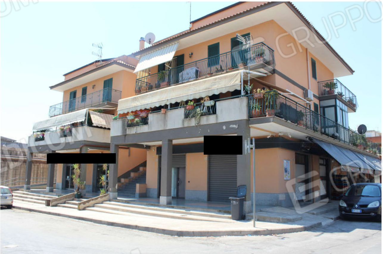
Foto n. 2 – Vista fabbricato in condominio
