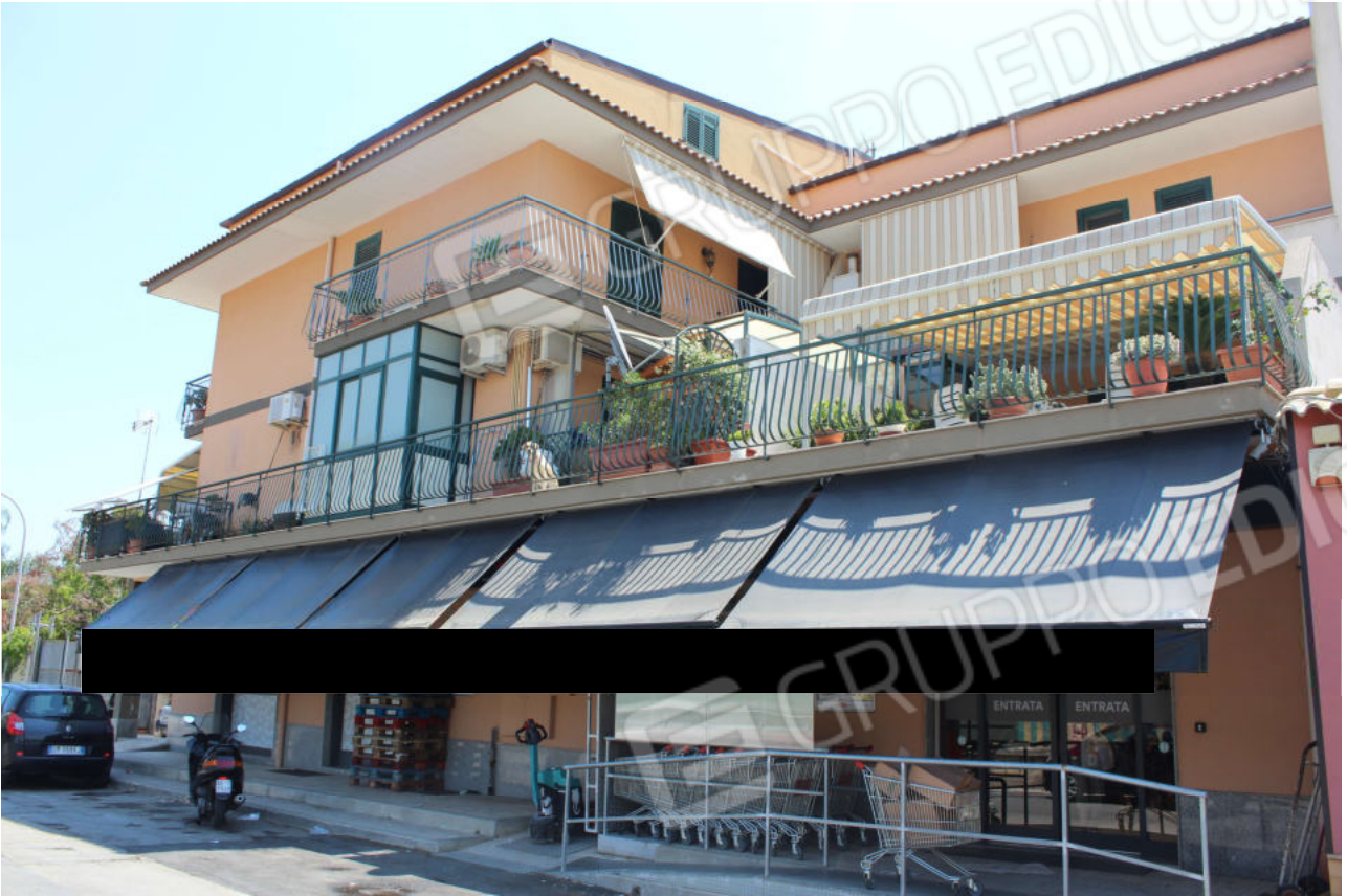
Foto n. 3 – Vista fabbricato in condominio laterale
