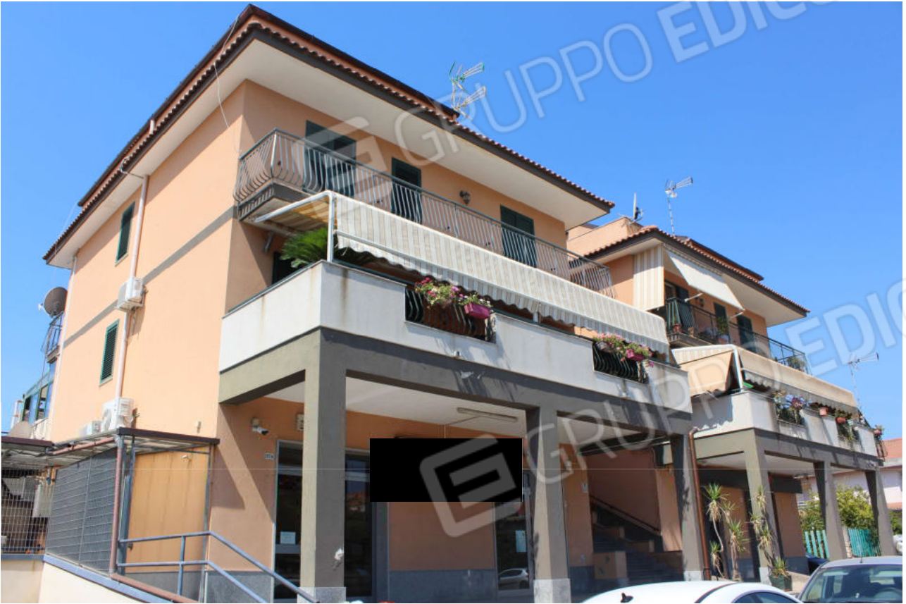
Foto n. 1 – Vista fabbricato in condominio
