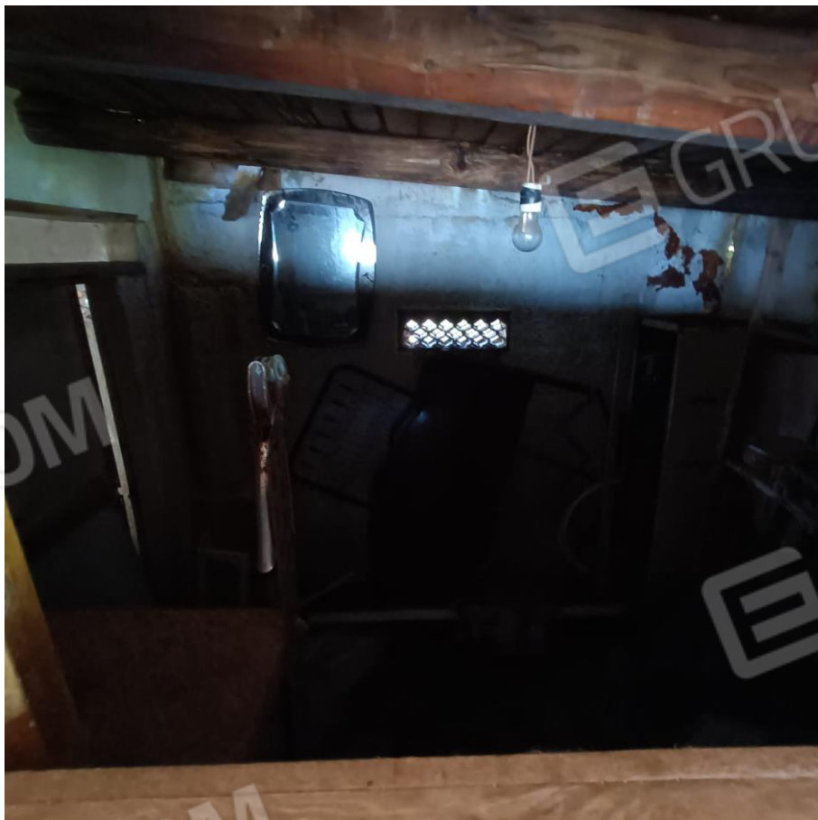
FOTO n.20 - Locale deposito da demolire
