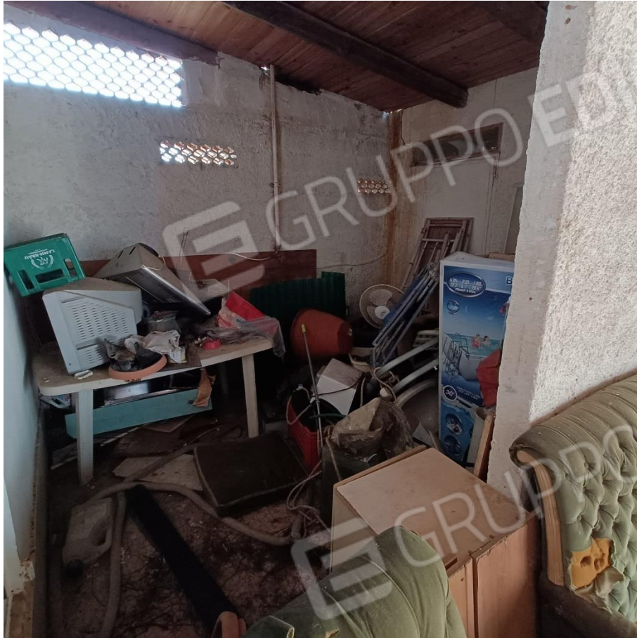
FOTO n.19 - Locale deposito da demolire
