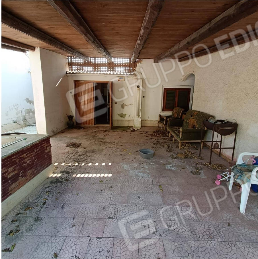
FOTO n.3 - Portico a sud-ovest
