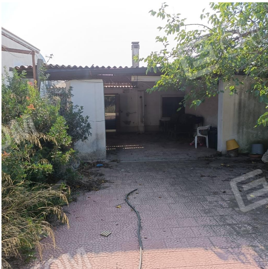
FOTO n.2 - Portico a sud-ovest
