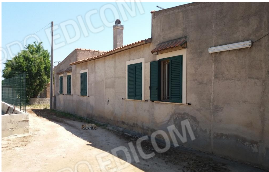
Foto 3 – Fabbricato rurale (versante Ovest)
