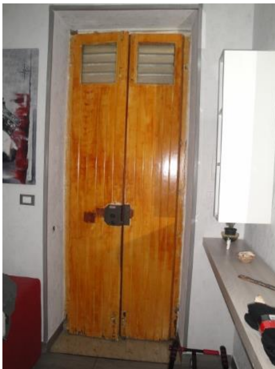
foto 1_vista interna del portoncino d'ingresso all'unità immobiliare
