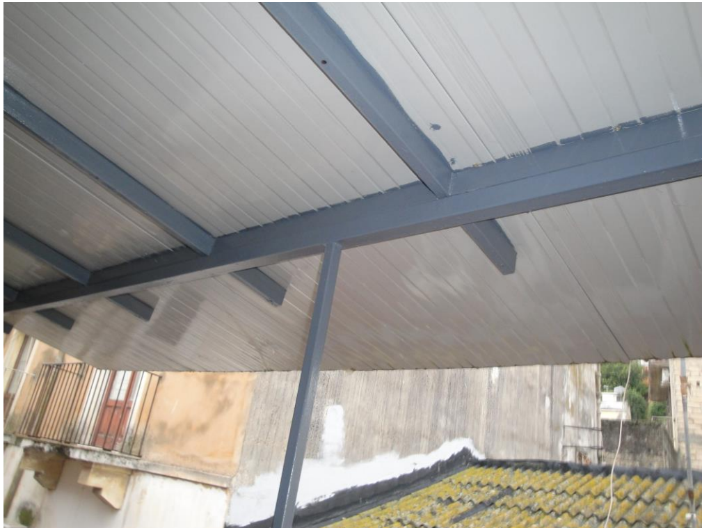
foto 7_ vista della copertura del terrazzino
