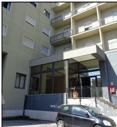
17_Ingresso laterale_corpo B
