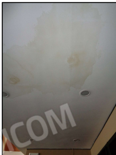
34_Particolari_infiltrazioni dal lastrico solare
