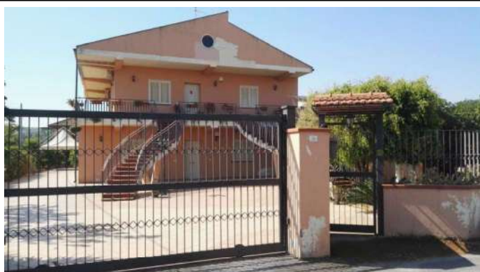
Foto 1 - Prospetto Nord su stradella privata di accesso
