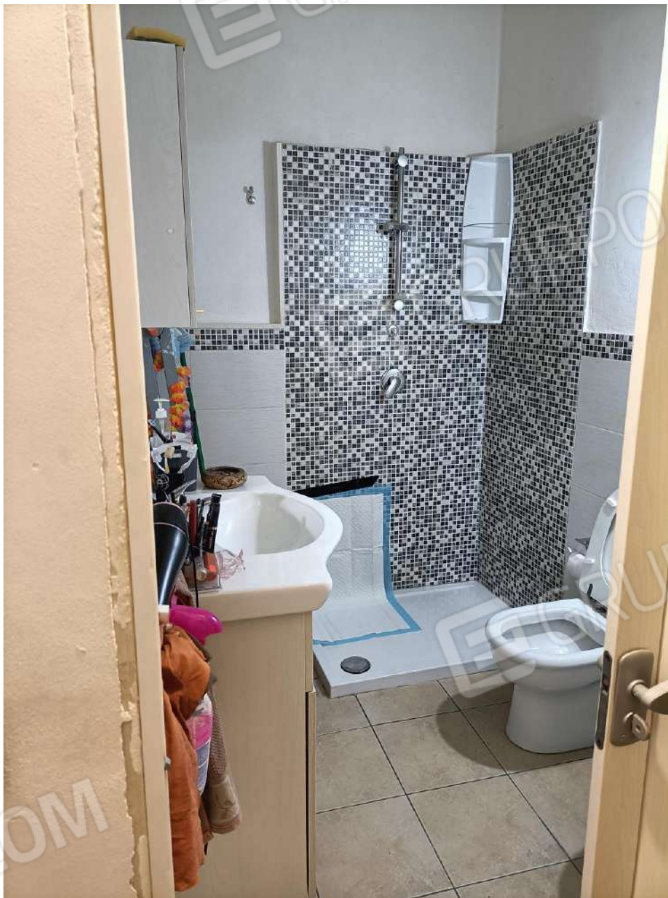
Foto 5. Vista del WC.
