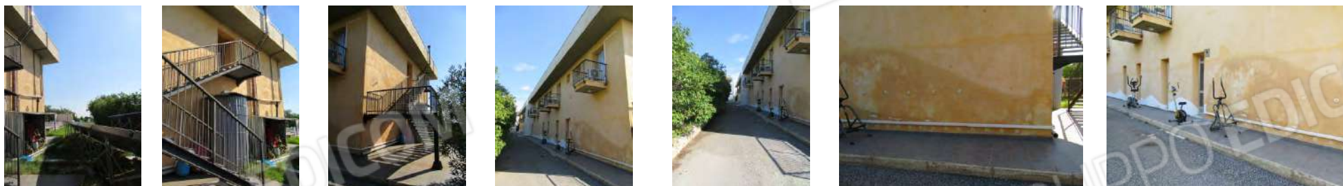
Foto da 251 a 254 – Prospetto Ovest
