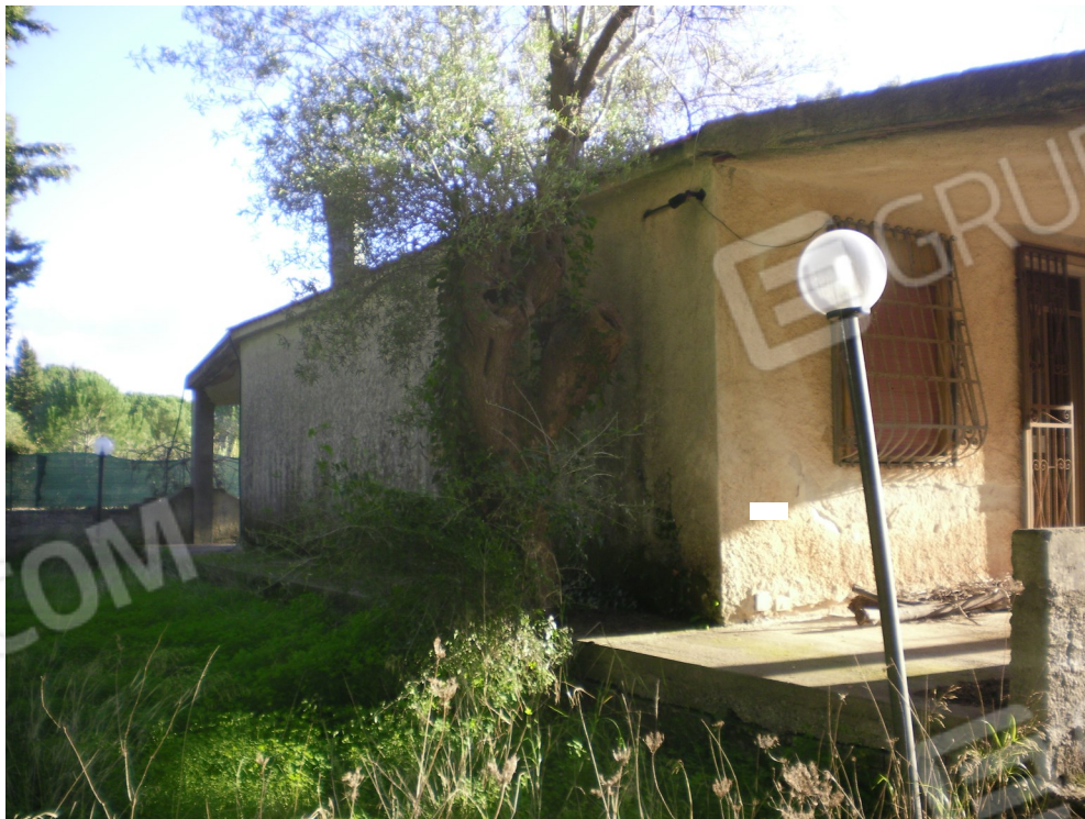
Foto 04: Vista prospetto Nord
