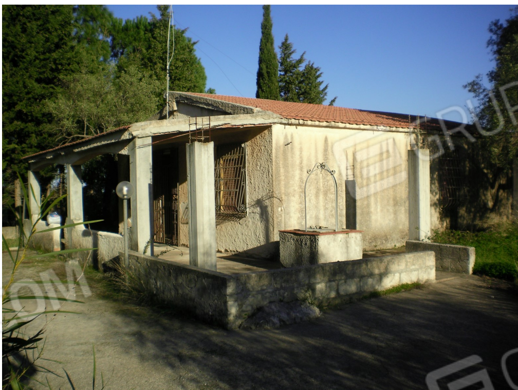
Foto 02: Vista prospetto Sud- Ovest
