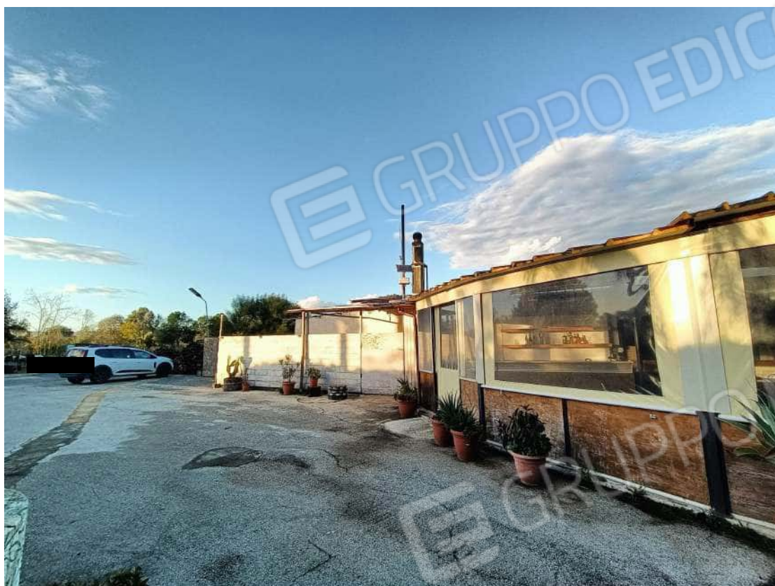
8 – Vista esterna del locale ristorante-pizzeria (Fig.65 p.lla 435)
