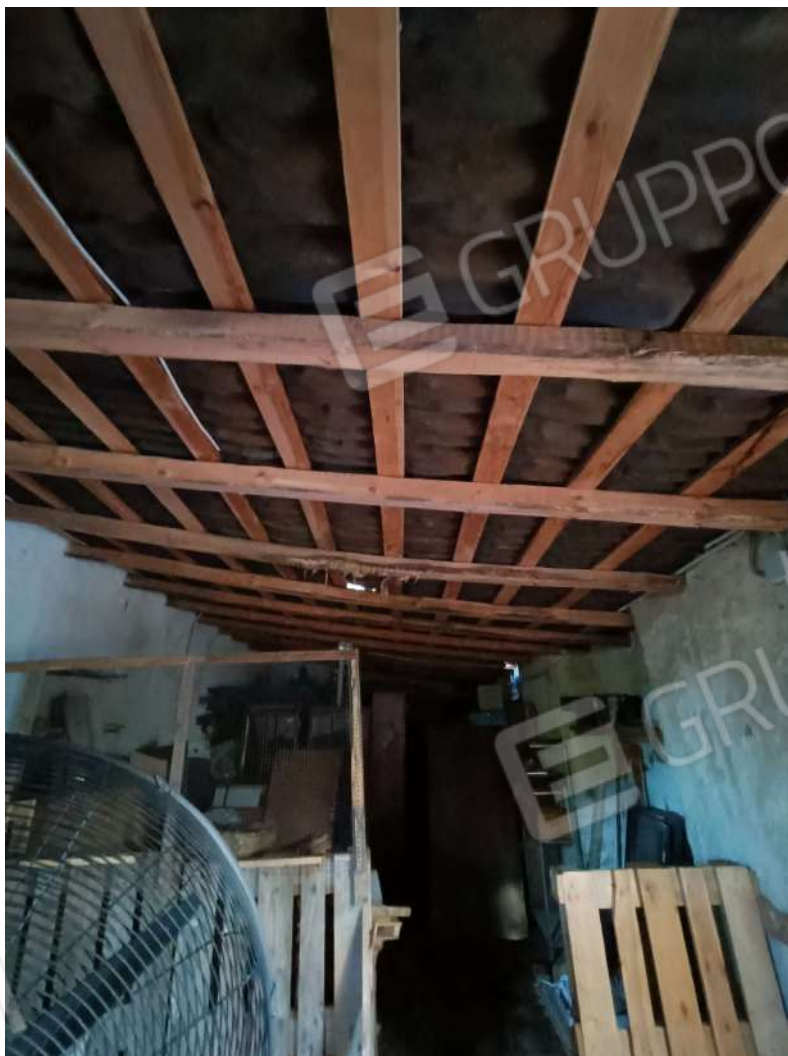
6 - Vista interna fabbricato rurale (Fig.65 p.lla26)
