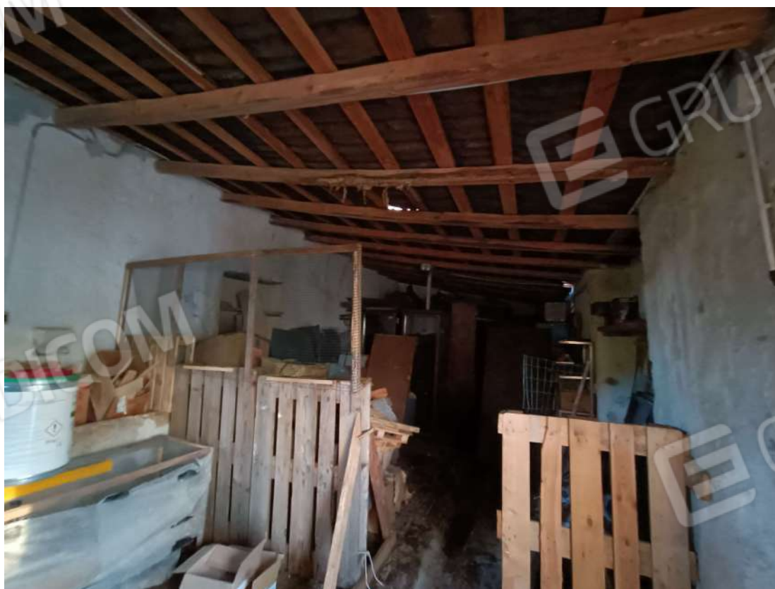
5 - Vista interna fabbricato rurale (Fig.65 p.11a26)
