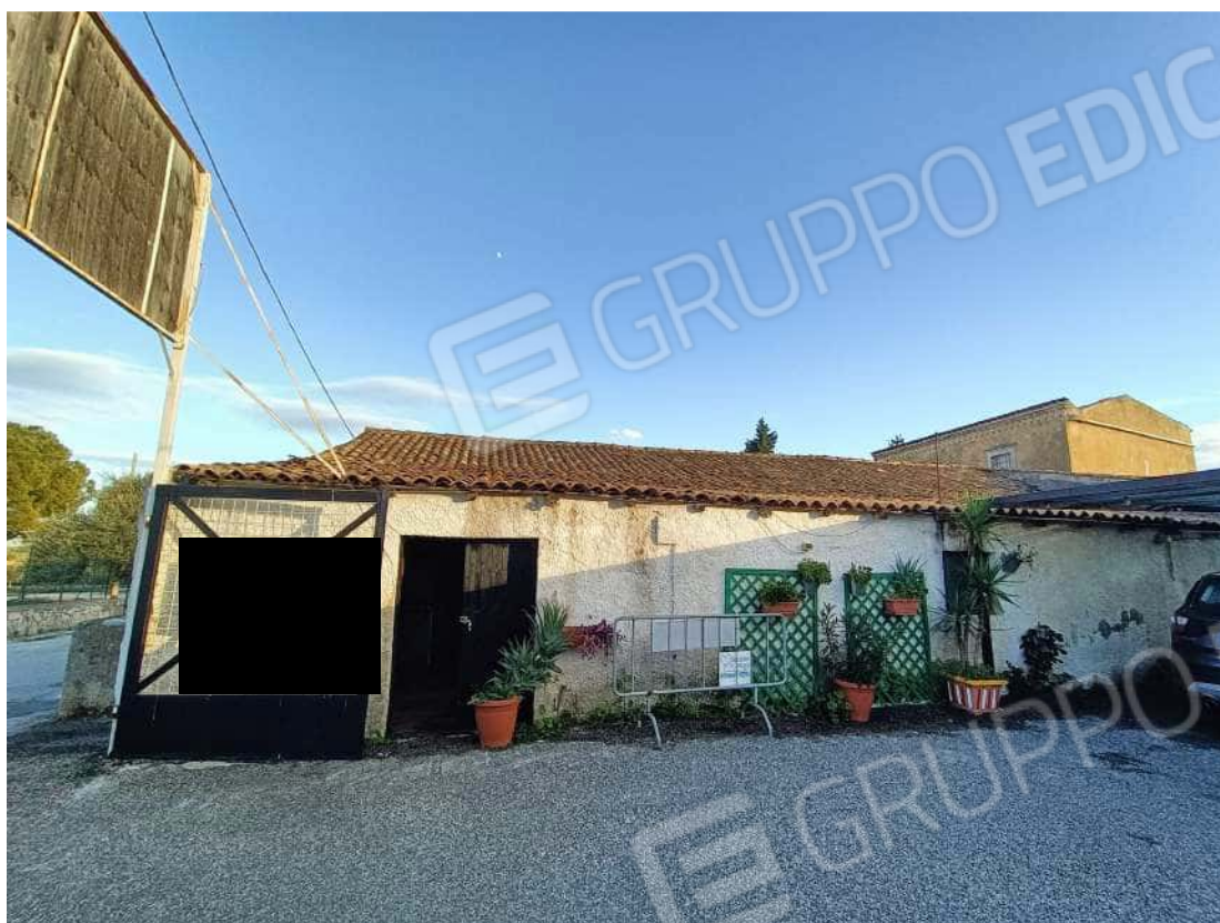
2 – Vista esterna fabbricato rurale (Fig.65 p.lla 26)
